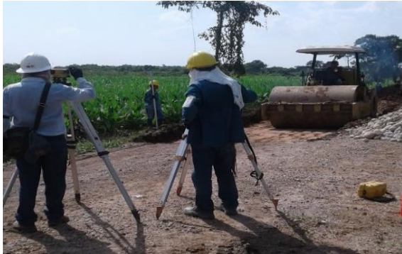
Presión al relleno con piedra bola
