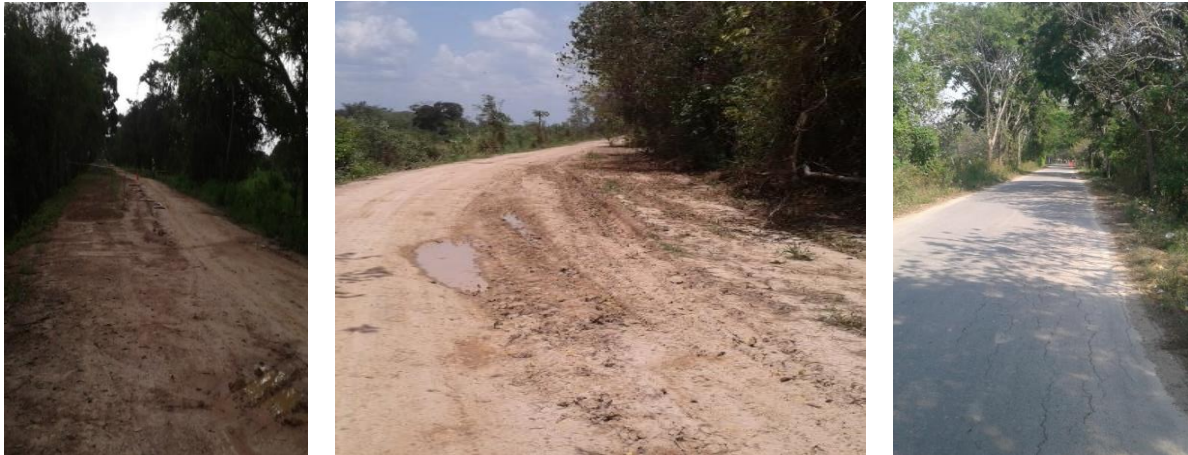
Figura 3. Estado inicial de la vía. Adaptado de S&M SOLUCIONES PROFESIONALES S.A.S
