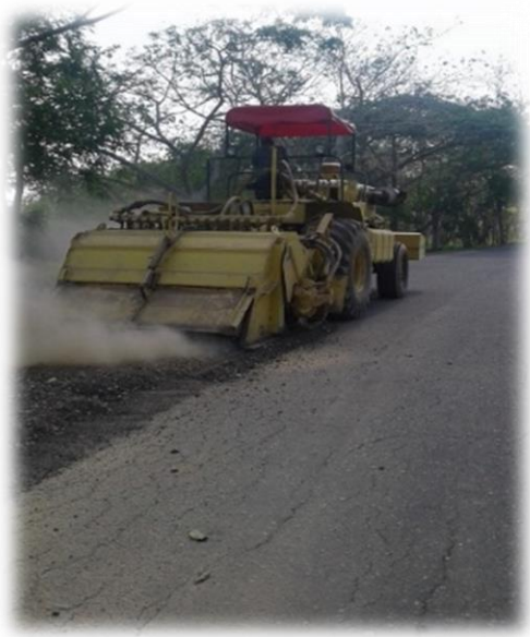
Figura 5. Actividad de fresado de pavimento asfaltico
