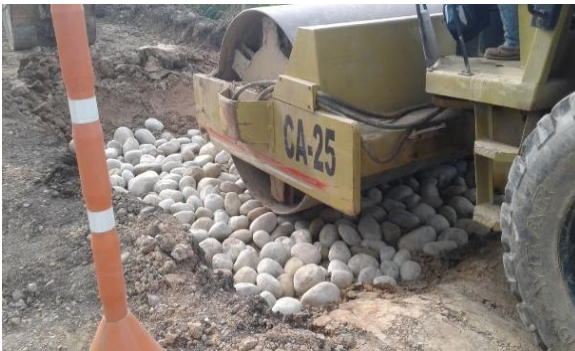
Compactación de material granular de tamaño máximo 4'' (crudo)
