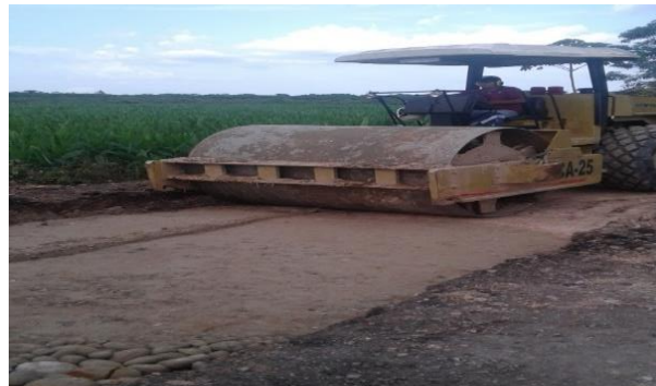
Compactación de material granular de tamaño máximo 4'' (crudo)
