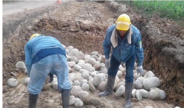
Relleno con material granular de tamaño máximo 4'' (crudo)
