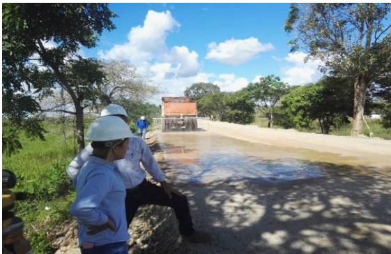
Figura 9. Proceso constructivo subbase granular
