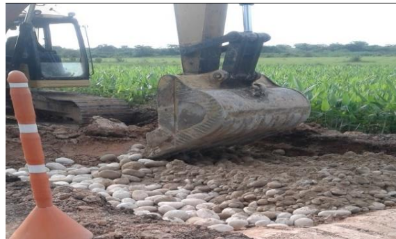
Compactación de material granular de tamaño máximo 4'' (crudo)
