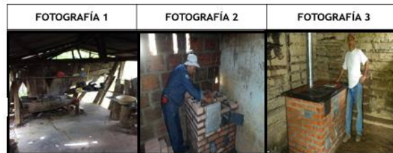
Figura 16. Proceso construcción hornillas ecológicas.
