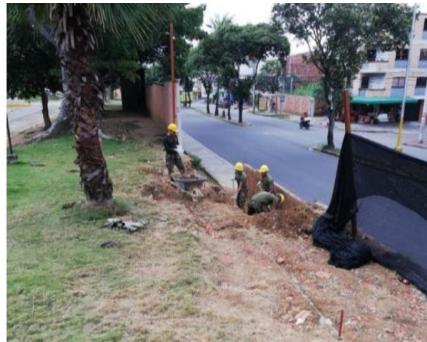
Figura 21. Excavación fase 1 del muro perimetral.
