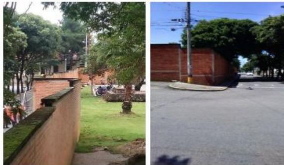
Figura 19. Muro perimetral existente.
