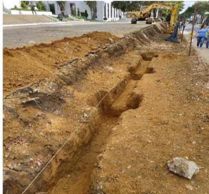
Figura 22. Excavación fase 2 del muro perimetral
