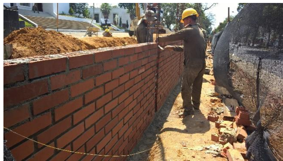
Figura 25. Colocación de mampostería.
