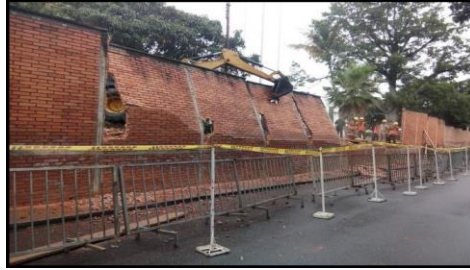
Figura 20. Demolición muro existente.
