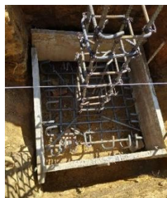
Figura 23. Figuración acero zapata con columna.
