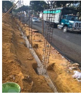
Figura 24. Cimentación del muro perimetral.
