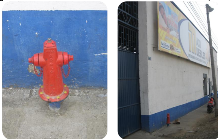
Figura 25. Hidrante ubicado en las instalaciones de la empresa
