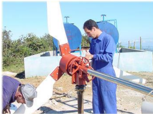
Imagen 7. Montaje aerogenerador eólico.
