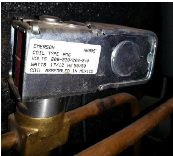
Figura 10. Válvula solenoide Emerson.
