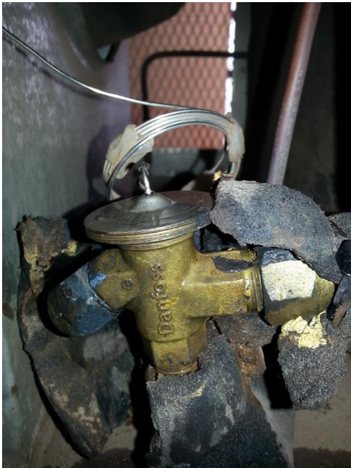
Figura 8. Válvula de expansión termostática.
