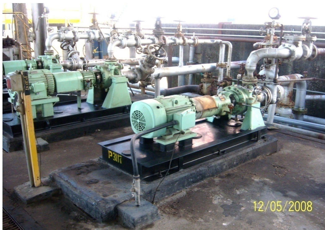
Foto 13. Bomba P-3117, cumple con la Norma API, plan 11
