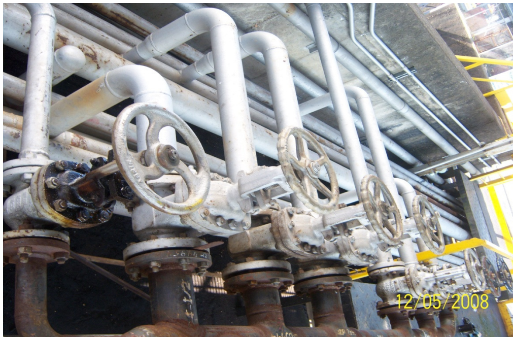
Foto 9. Sistema Manifold de descarga de la Bomba P-3131, Spare de Disolventes
