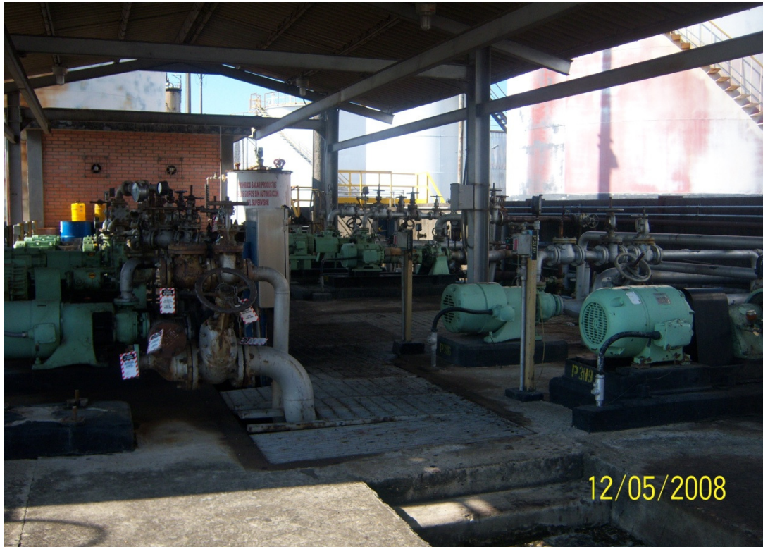
Foto 9. Sistema Manifold de descarga de la Bomba P-3131, Spare de Disolventes
