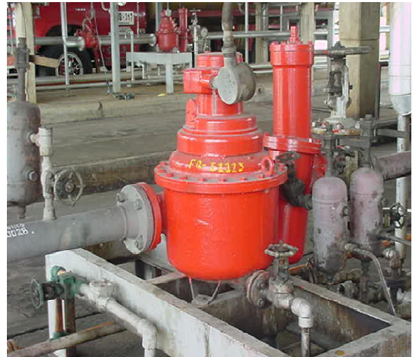
Foto 4. Medidor de desplazamiento positivo
