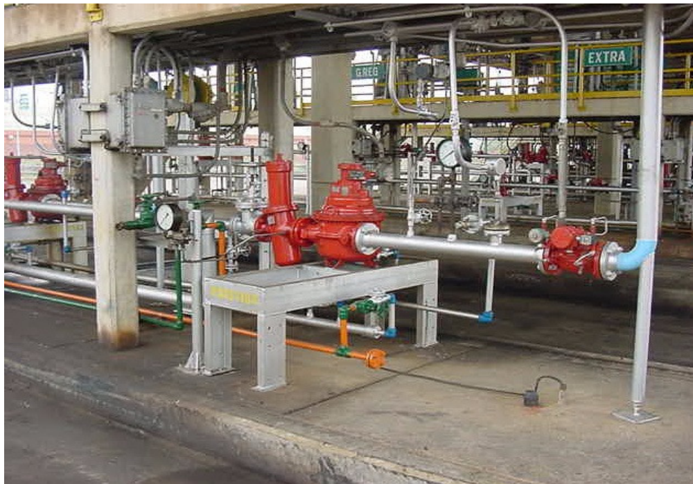
Foto 2. Tren de medición en el llenadero
