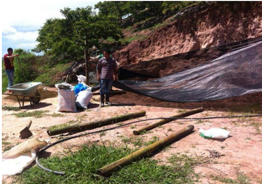
Figura 14. Adecuación del terreno
