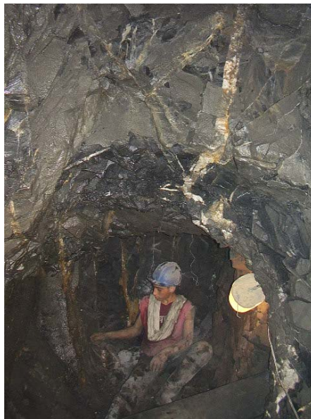
Figura 19. Aspecto de las rocas al interior del túnel 'El Trapiche', en la cual se observa una vena compuesta fundamentalmente de calcita-dolomita cortando la estratificación, esta se encuentra ubicada dentro de la zona II.
