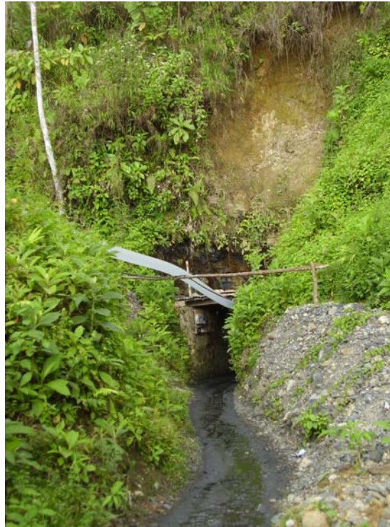
Figura 6. Aspecto de la entrada al túnel “El Trapiche”, cuyas coordenadas son Norte =1123593 y Este =999326
