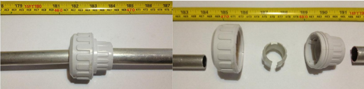
6.8.1.1.3 Fig. 81 Intervención a acople universal de tubería
