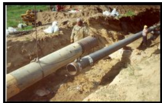
Figura 14. Alineación de tubos
