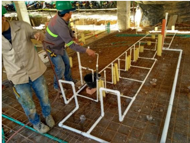
Figura 17. Prueba de presión para el baño piso 1 bloque A
