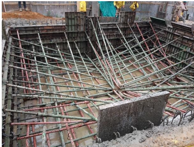
Figura 18. Apuntalamiento pre-vaciado de concreto.
