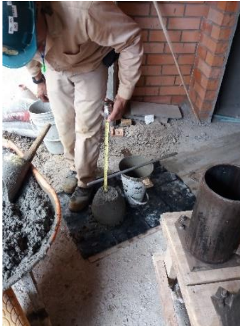
Figura 14. Prueba de asentamiento (slump) en obra.
