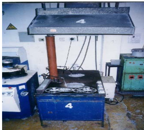
Figura A5. Horno de la sección de microfundición.
