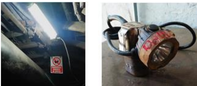
Figura 23. Iluminación de mina y de personal.
