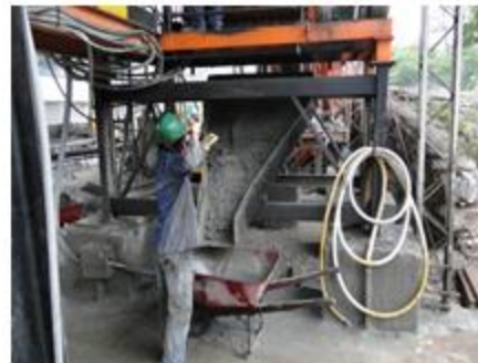
Figura 9. Llenado de las formaletas con la materia prima
