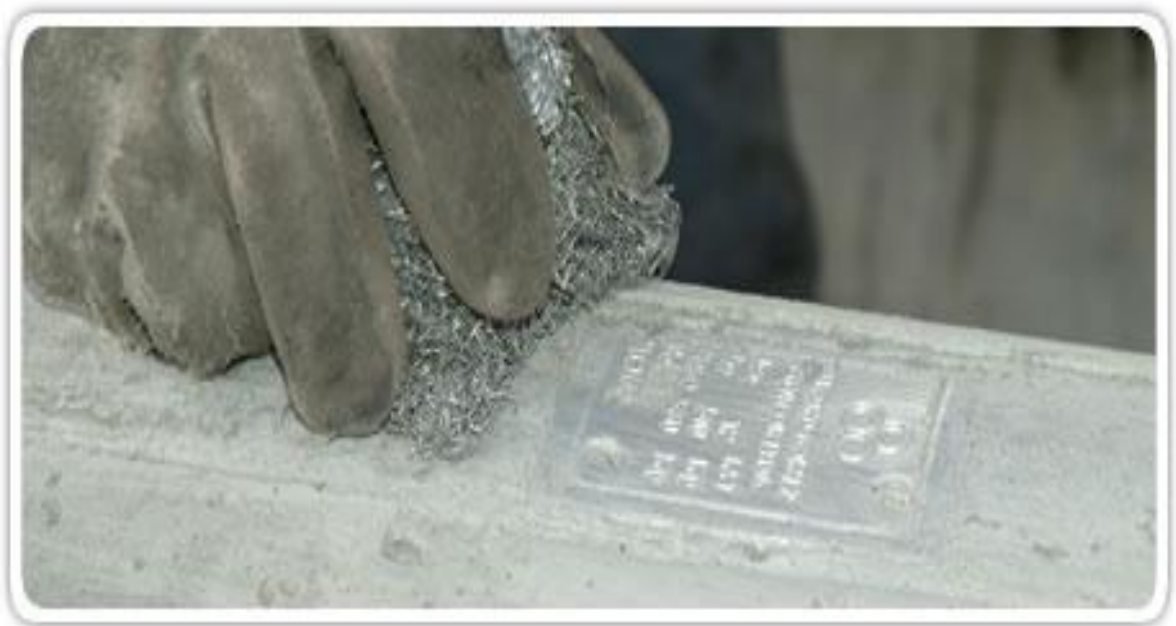
Figura 3. Placas con especificaciones del poste
