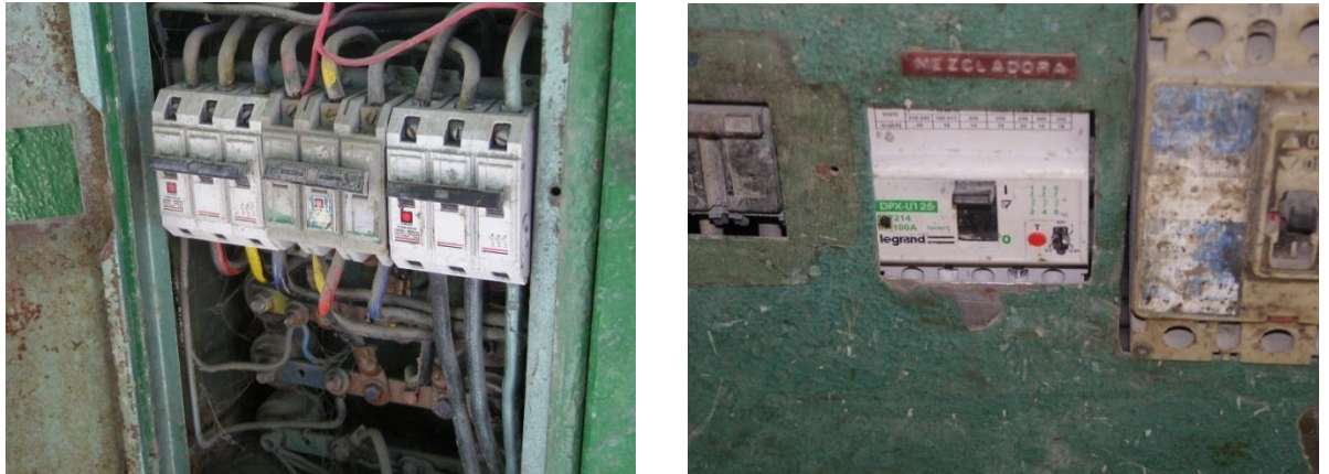
Figura 154. Cambio de tacos de Protección Mezcladoras Argentinas y Protección general
