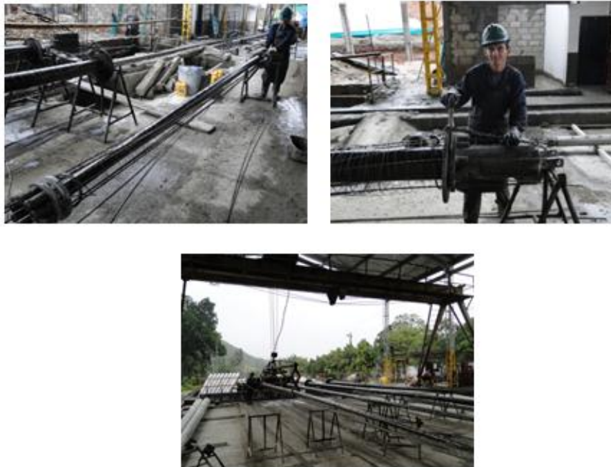
Figura 8. Refuerzo de acero
