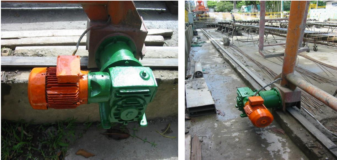
Figura 162. Mantenimiento puente grúa 3
