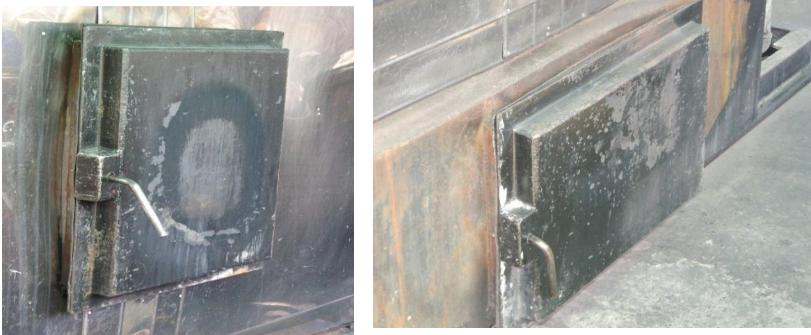
Figura 156. Cambio del aislante de las puertas de la caldera de 150 BHP
