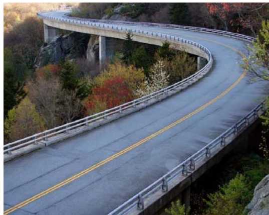
Figura 2.20 Viaducto de Linn de Linn Cove ya terminado.
