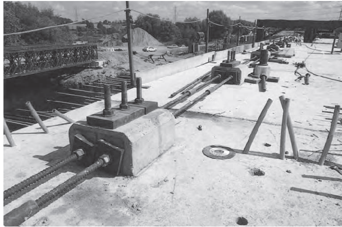
Figura 3.44. Sistema de preesforzado temporal mediante barras.
