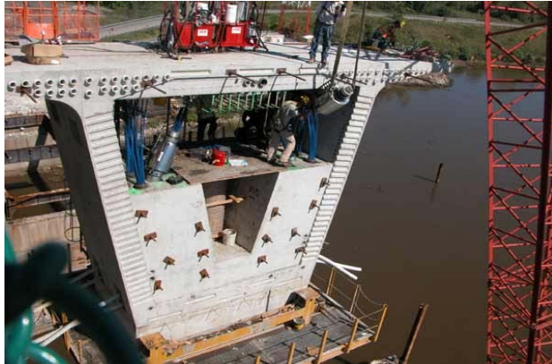
Figura 3.43. Dovela típica de pila.
