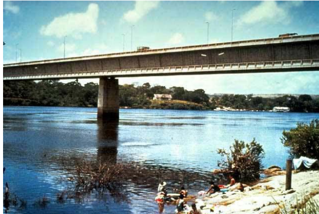
Figura 2.7. Puente del río Caroní en Venezuela (1962-1964)
