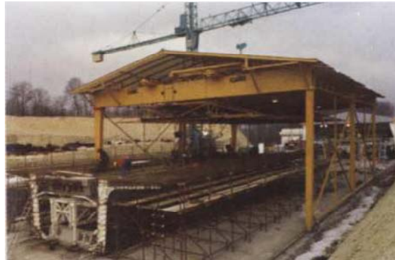
Figura 2.9 Planta de fabricación del tablero.
