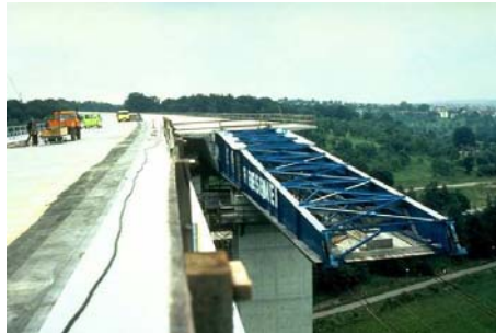
Figura 2.10 Nariz del puente utilizando el método de lanzamiento.
