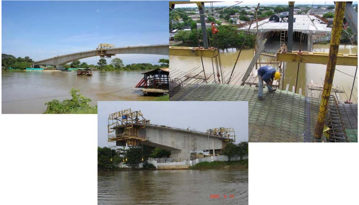
Figura 4.7. Puente sobre el río Sinú, Montería.
