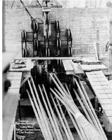
Figura 3.12 Extremo tipo zapato o Strand Shoes del anclaje este del puente Tacoma Narrows de 1940.
