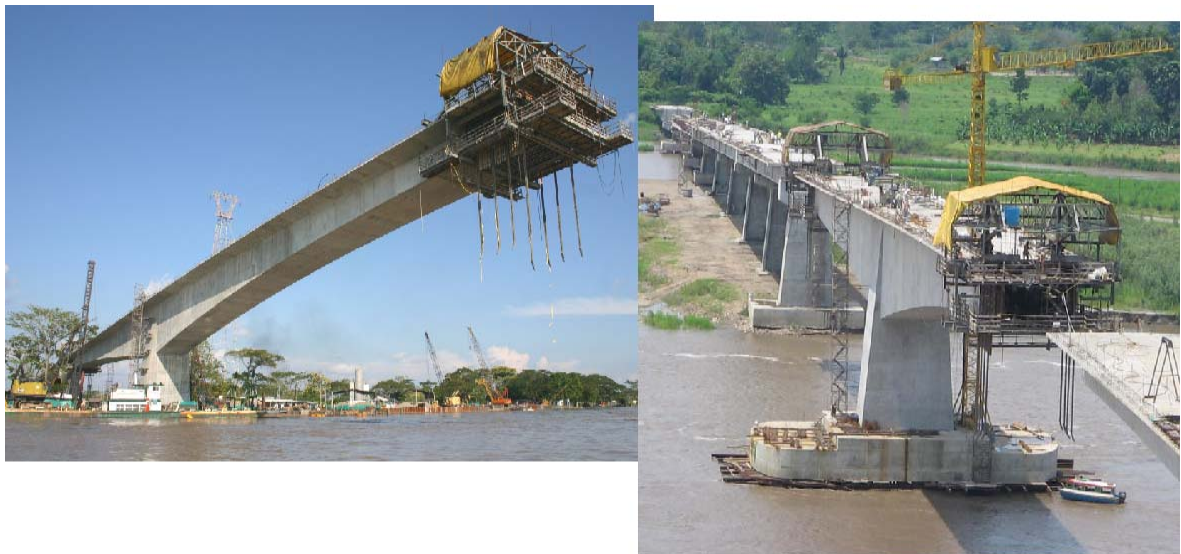
Figura 4.6. Puente de Barranca-Yondó sobre el Río Magdalena sobre el Estrecho Galán.
