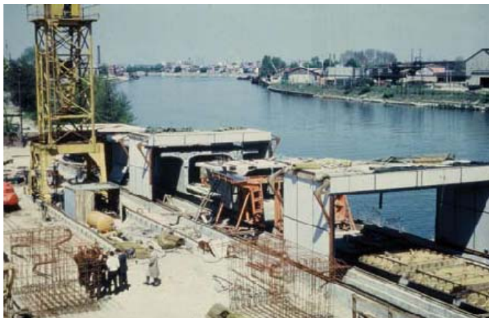
Figura 3.3 Superficie de fundición para prefabricados de Choisy-le-Roi en Paris, France.
