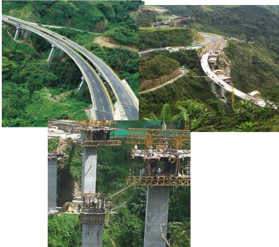
Figura 4.8. Viaducto La Estampilla. Carretera Pereira-Manizales
