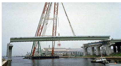
Figura 2.1 Viga de tramo luz a luz puesta con grúa.
