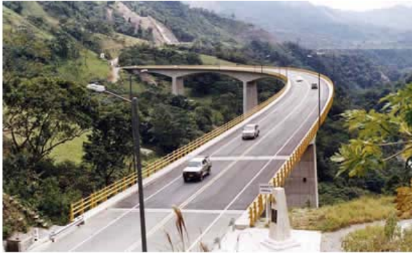
(1) Puente Pipiral en Servicio
