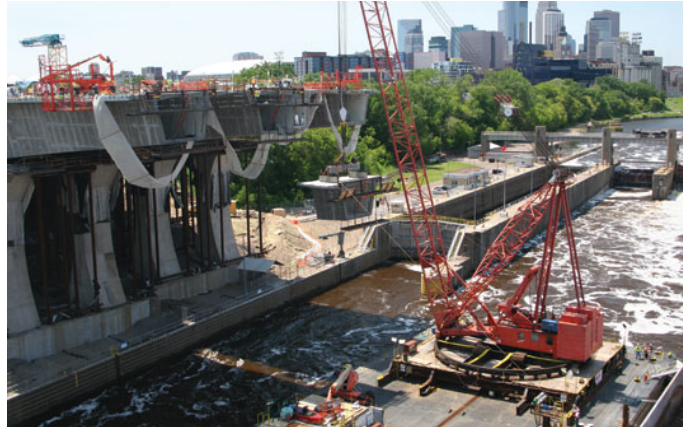
Figura 3.45. Erección de dovelas mediante grúa montada sobre una barcaza.
