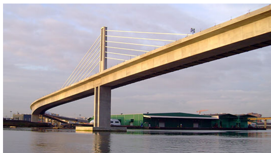
Figura 1.7 Puente The North Arm. Vancouver, Canadá.
