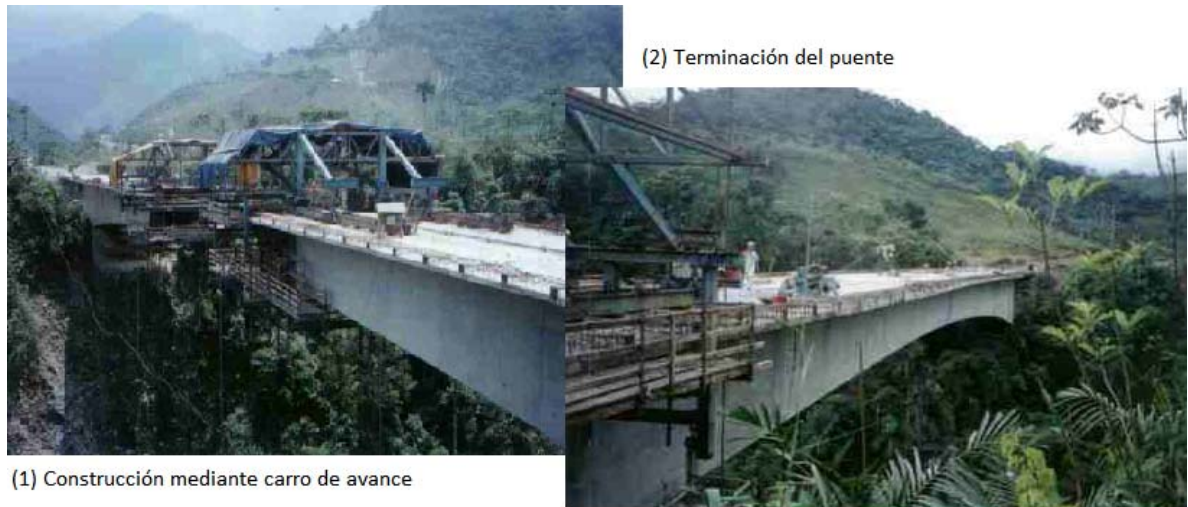
Figura 4.5. Puente de Sevitá, Autopista Bogotá-Villavicencio.
