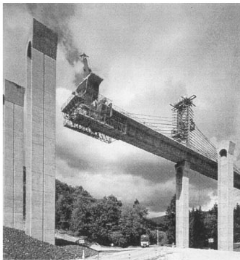
Figura 2.17 Viaducto de Fréburge, Francia. Construcción usando torre movable con sistema de cables
