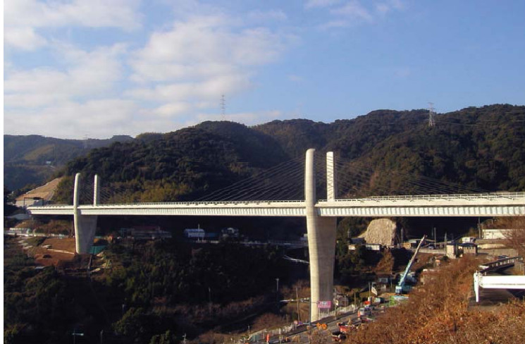
Figura 1.16 Puente Himi. Japón. (Mástiles en "Y")
