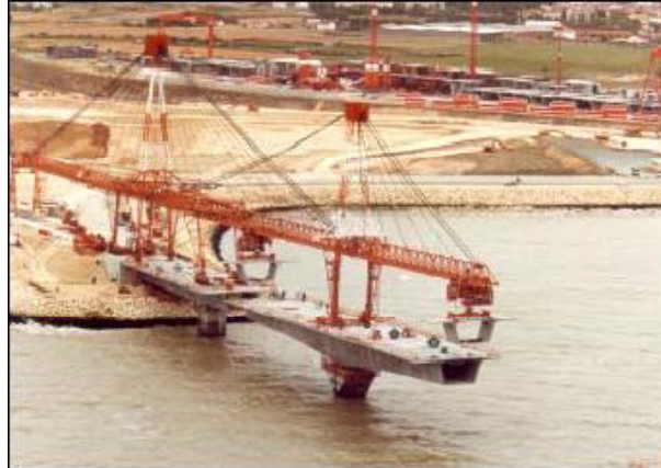
Figura 3.48. Erección de dovelas mediante viga lanzada soportada por tirantes.
