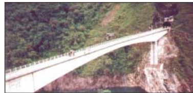
(2) Entrada al tunel
