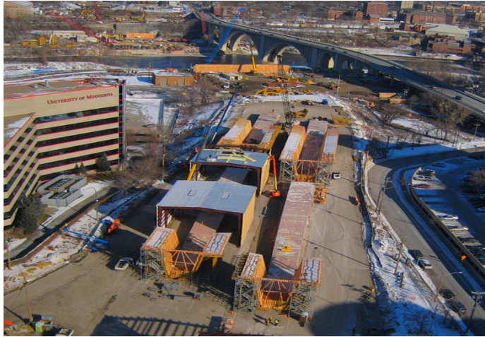
Figura 3.35. Planta de prefabricación de segmentos (Casting's Yard).
