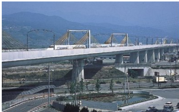
Figura 1.11 Puente Yasiro. Japón (Dos planos de cables extradosados)
