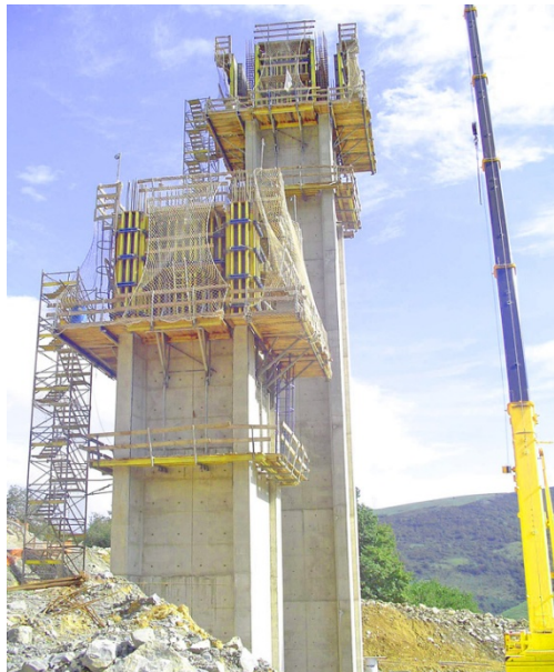
Figura 3.6. Pila doble pared. Autovía A-67 del Cantábrico a la Meseta, Cantabria
