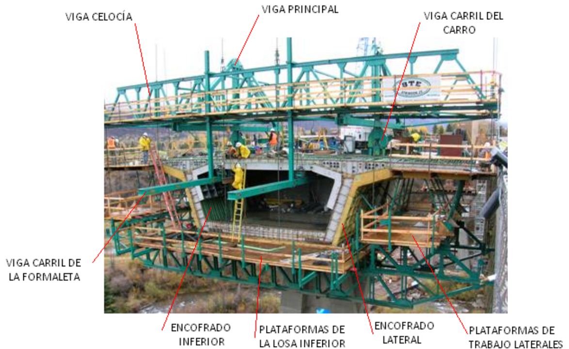
Figura 3.30 Esquema de un carro móvil tradicional con vigas principales situadas encima de la losa superior.
