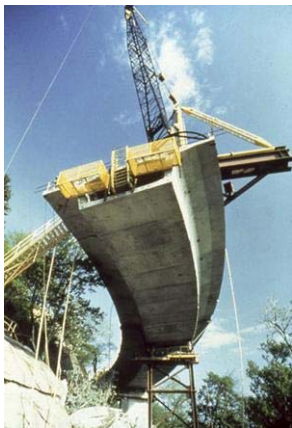
Figura 2.19 Construcción del Linn Viaducto Cove.
