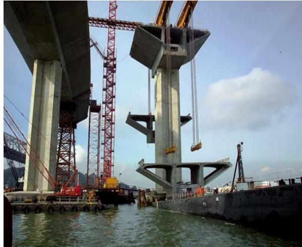
Figura 3.46. Erección de dovelas transportadas en barcazas mediante piernas de cortante (shear legs).
