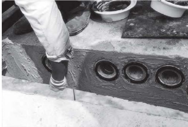
Figura 3.41. Aplicación manual de resina epóxica en dovelas
