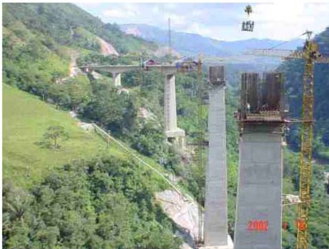
(3) Construcción del puente con dovelas fundidas en sitio
