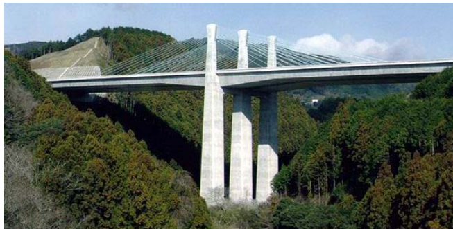
Figura 1.12 Puente Miyakodagawa, Japón (Tres planos de cables extradosados)
