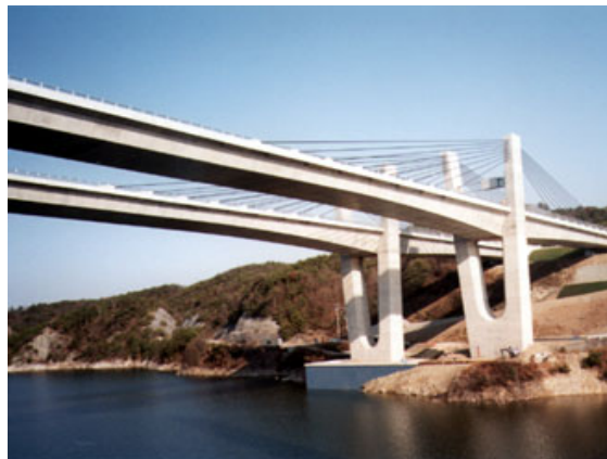
Figura 1.15 Puente Tsukuhara. Yamada-cho, Kobe (Mástiles en "V").
