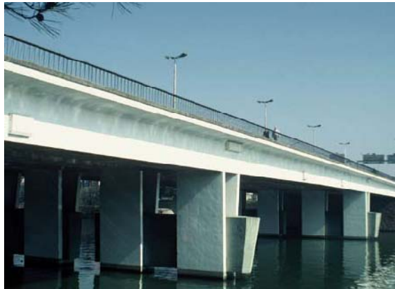
Figura 3.2 Puente sobre el río Sena en Choisy-le-Roi. Francia
