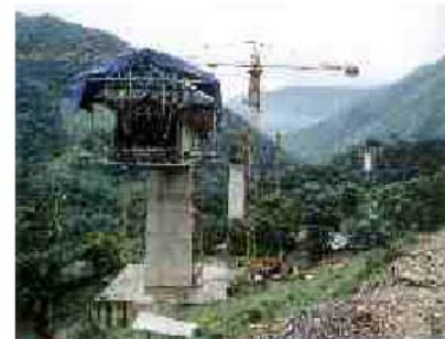
(4) Construcción de una pila.
