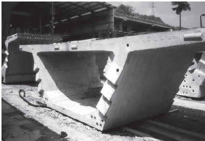
Figura 3.42. Llaves de cortante en dovelas prefabricadas.
