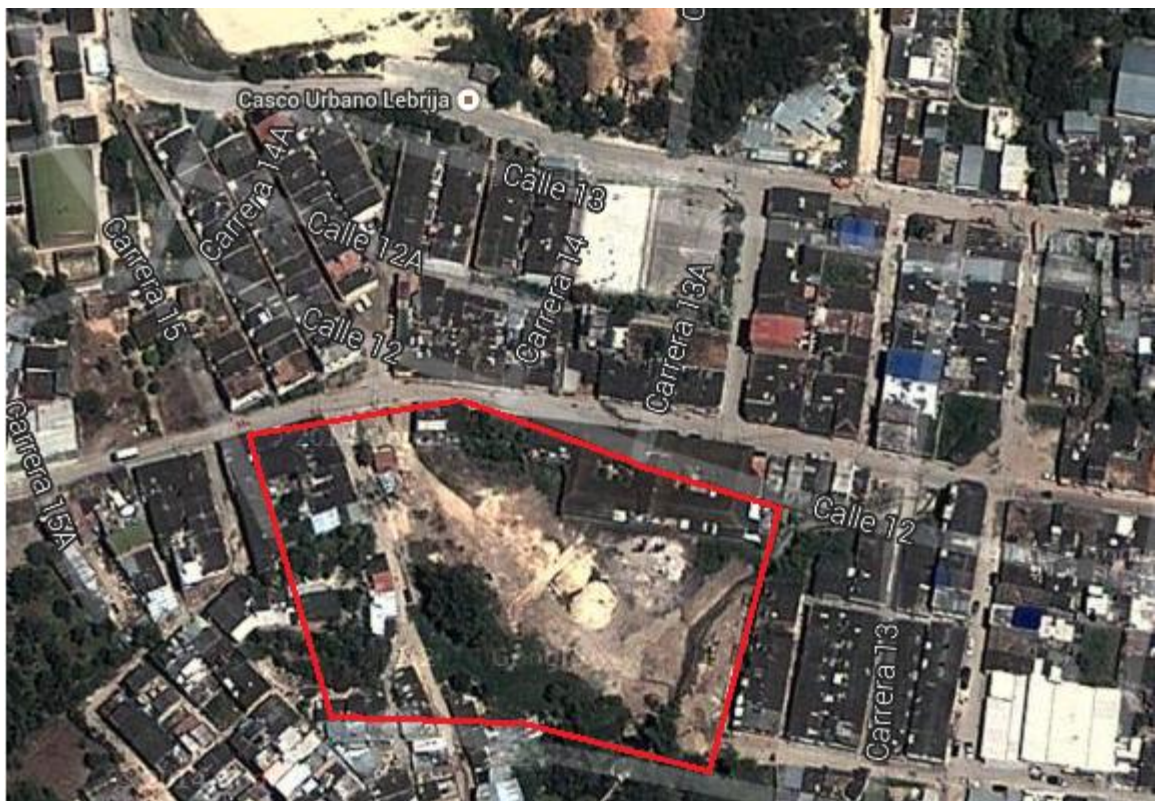
Figura 24. Conjunto residencial Briales
