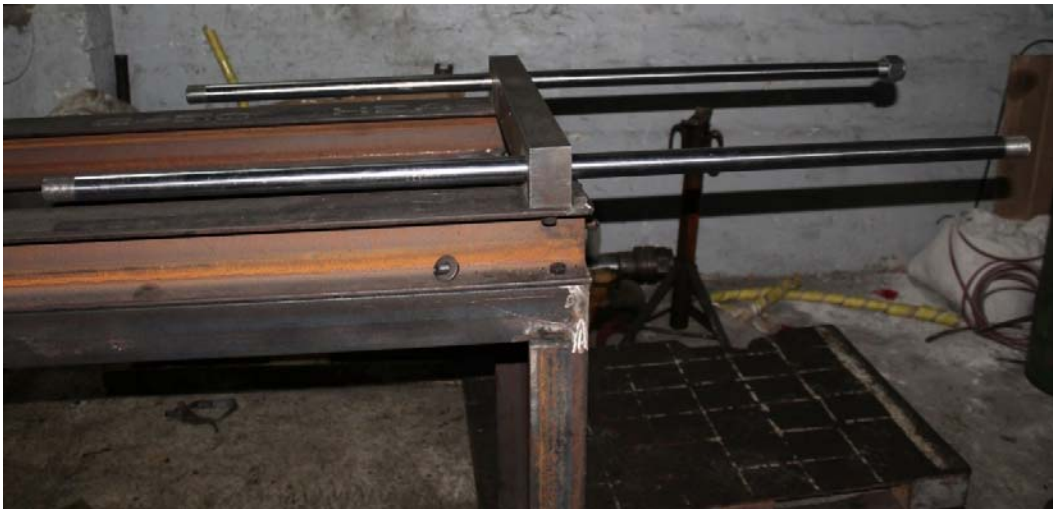
Figura 74. Ensamblaje de las guías a la estructura
