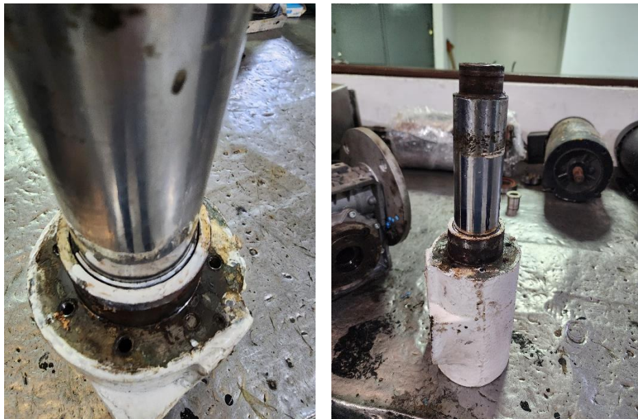
Figura 4. Rotura en los tornillos de sujecion del cilindro con el brazo de sujecion y detalles de la ralladura del cilindro por efecto de la desalienación.
