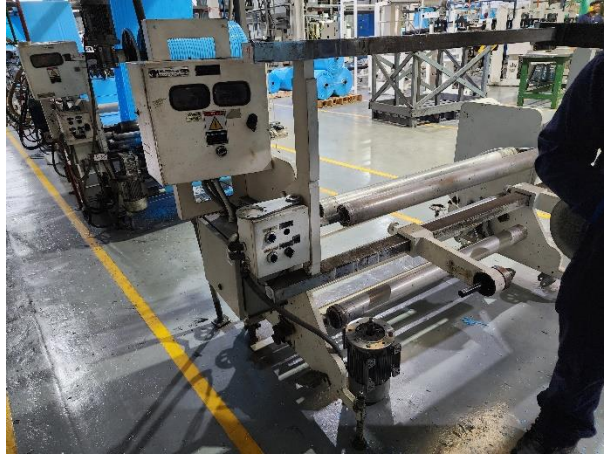
Figura 7. Evidencia de equipos desmontados o desensamblados.
