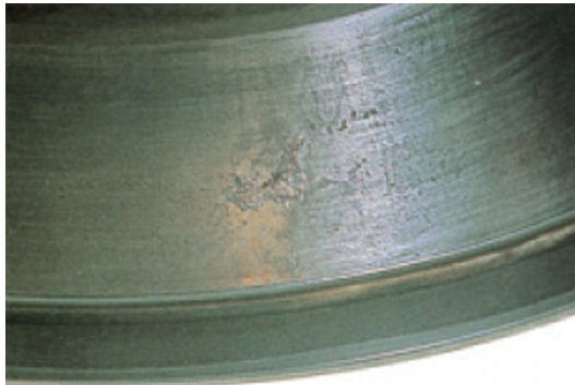
Figura 43. Descascarado causado por muescas previas.
