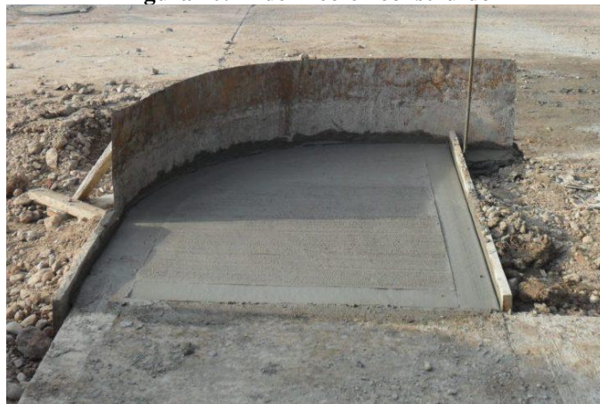
Figura 40. Andén recién construido
