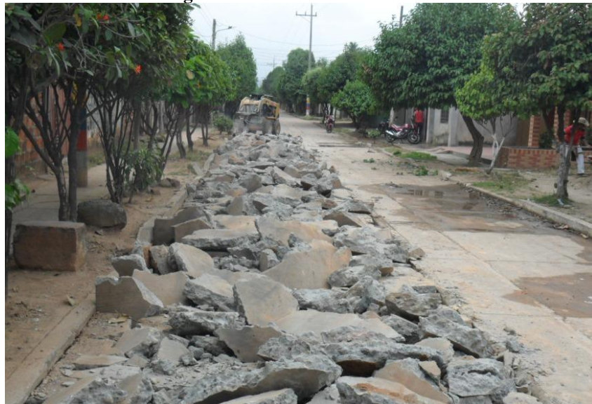
Figura 7. Demolición de andenes
