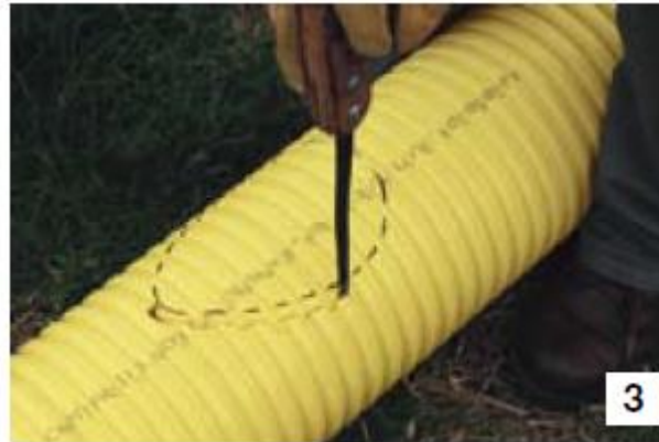
Figura 21. Perforación de la tubería con serrucho
