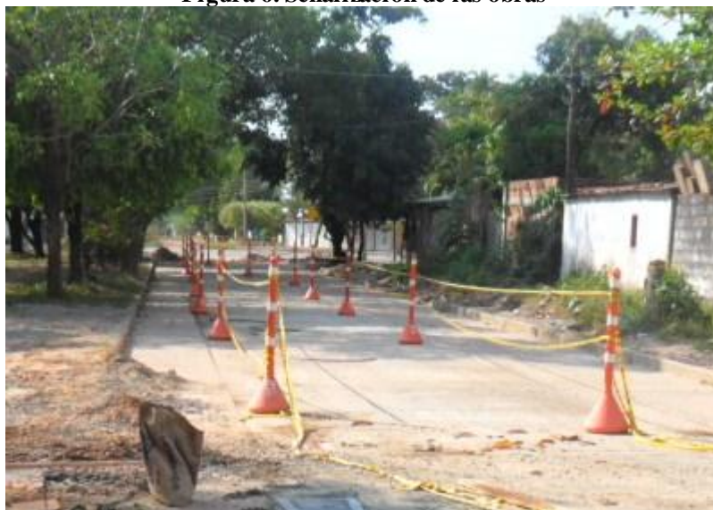
Figura 6. Señalización de las obras
