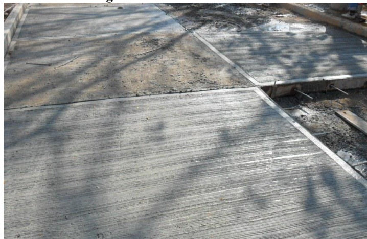
Figura 38. Acabado en concreto
