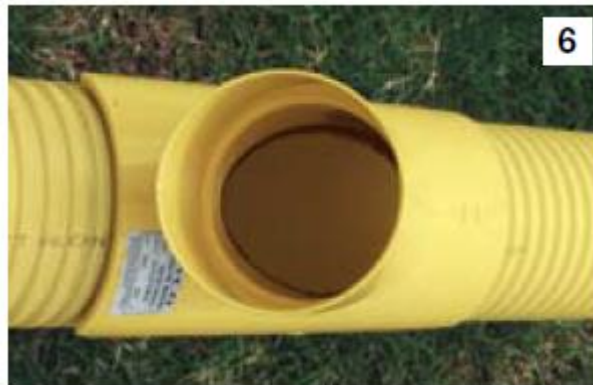
Figura 24. Colocación de la silla
