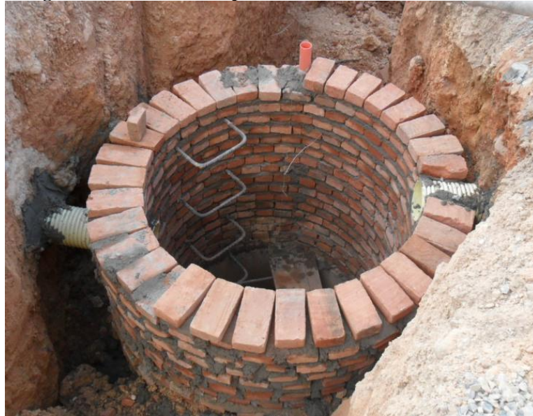
Figura 30. Cámara de inspección cilíndrica en construcción
