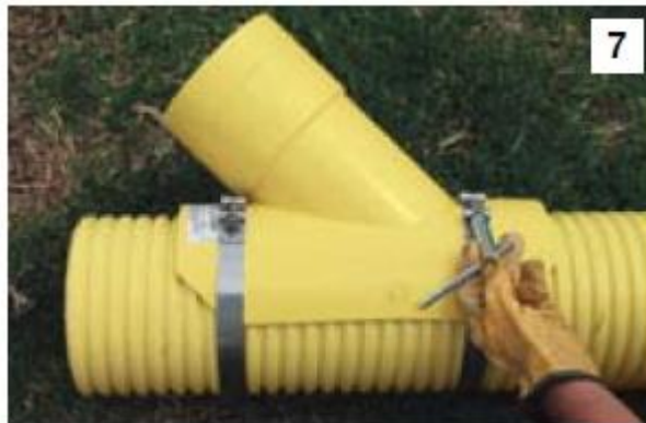
Figura 25. Colocación de las abrazaderas
