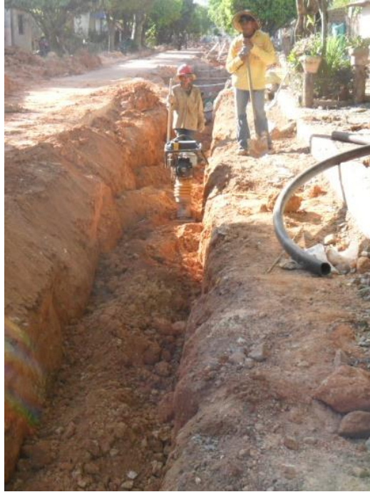
Figura 35. Compactación del relleno
