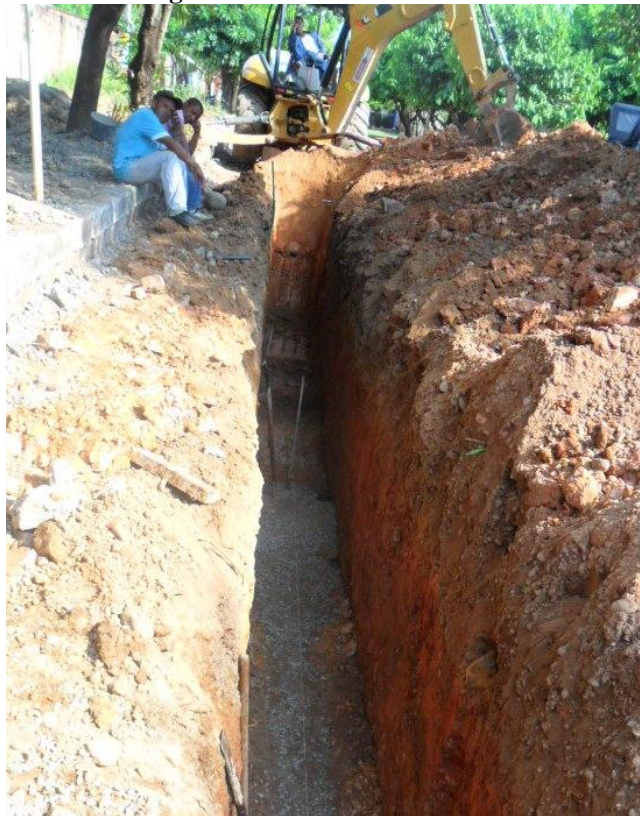
Figura 10. Excavación mecánica
