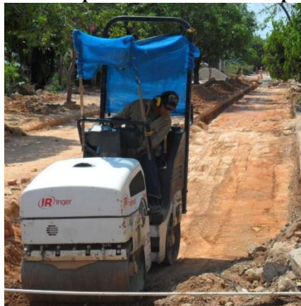
Figura 36. Compactación con vibrocompactador.
