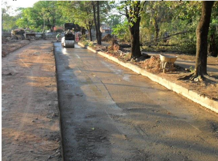
Figura 37. Conformación de base granular para pavimento
