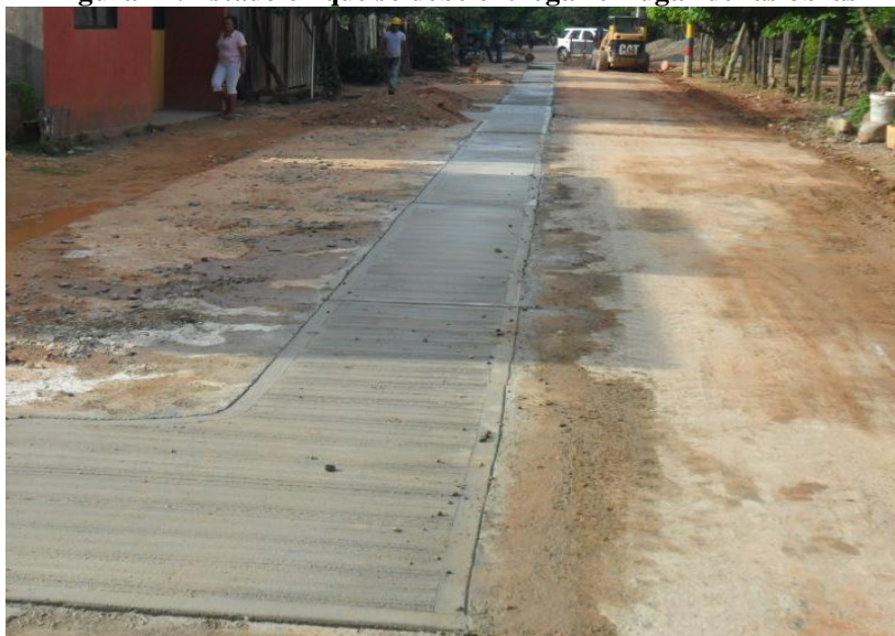
Figura 41. Estado en que se debe entregar el lugar de las obras
