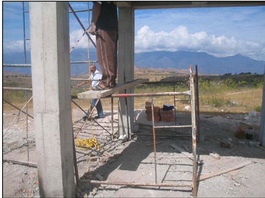
Foto 2. Construcción Tanque Elevado acueducto Rural
