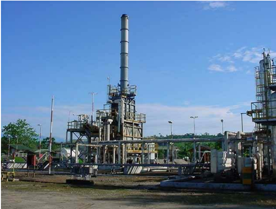
Figura 1. Estado Actual Refinería Orito.
