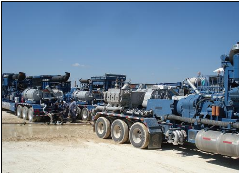
Figura 11. Unidades de Bombeo.
