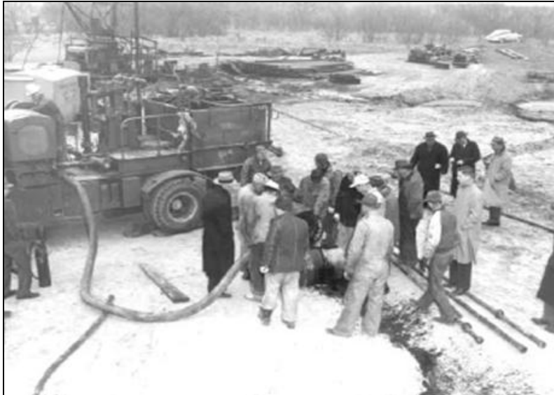
Figura 2. Primeros Trabajos Realizados.
