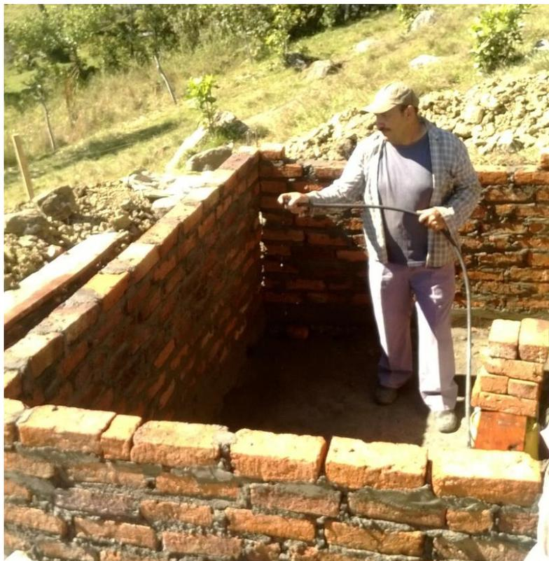
Figura 54. Vista superior del tanque de almacenamiento con capacidad de 9 m<sup>3</sup>.
