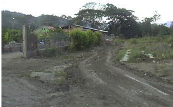
Figura 20 Estado Final De La Nueva Vía de Acceso Al Área Productiva
