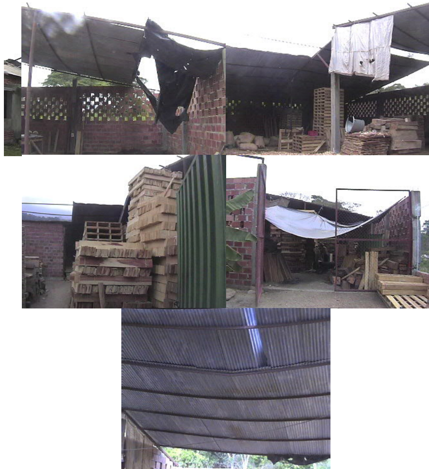
Figura 19 Fotografías De Las Condiciones Iniciales Del Techo
