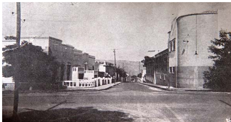
14. Avenida 22 en la que por iniciativa de la Sociedad de Mejoras se instalaron bancas.
