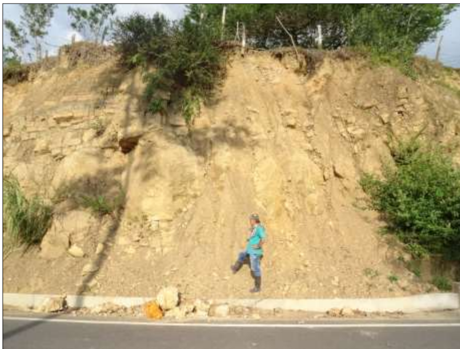
Figura 9. Afloramiento de arenisca amarilla.
