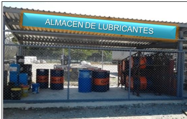
Foto 1. Exterior almacén de lubricantes
