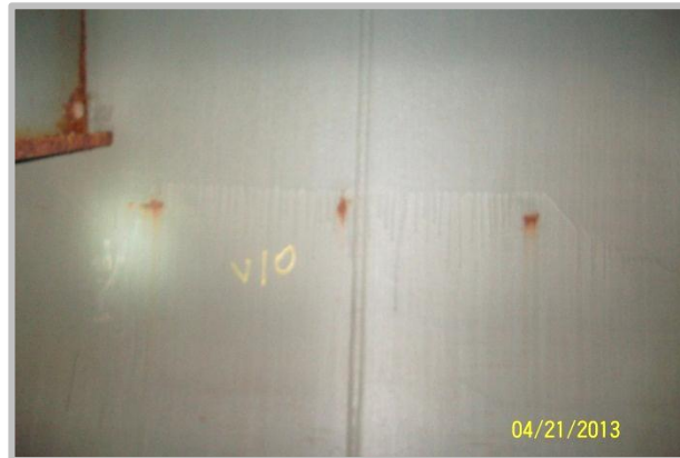
Fotografía 24: Soldadura interna del cuerpo de la bala B-TK-001
