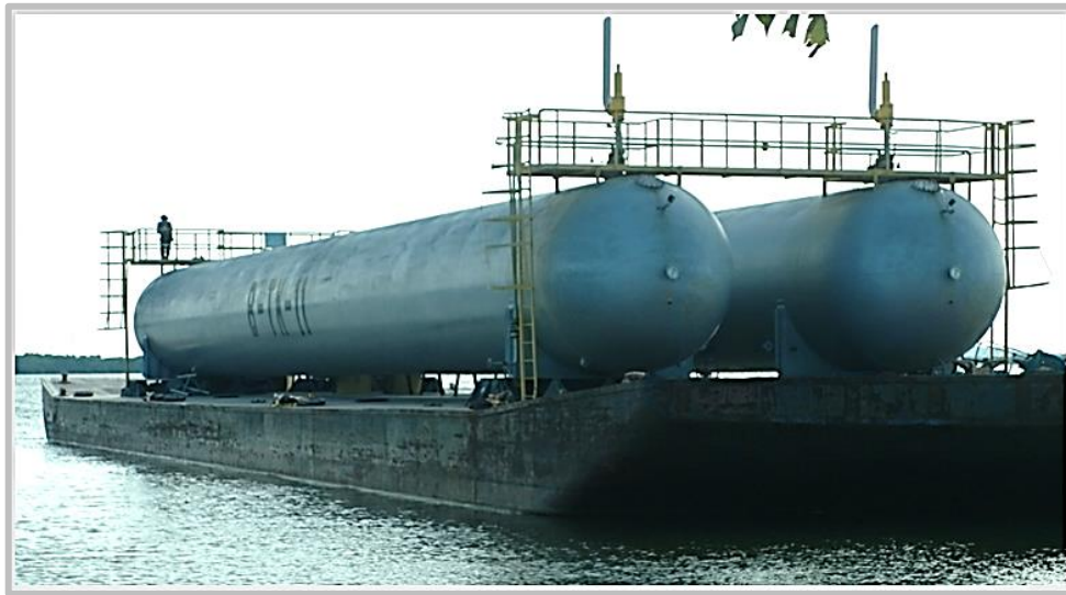
Fotografía 4: Panorámica de la bala sobre la barcaza a inspeccionar.
