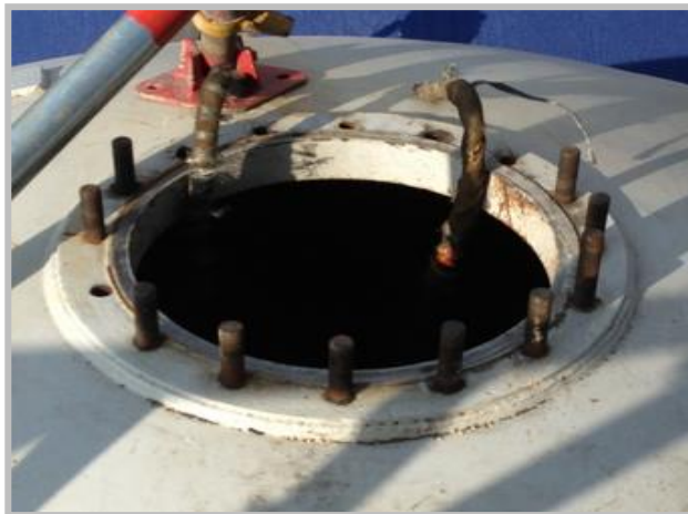
Fotografía 32: Manhole ubicado en la parte superior del cabezal 1.
