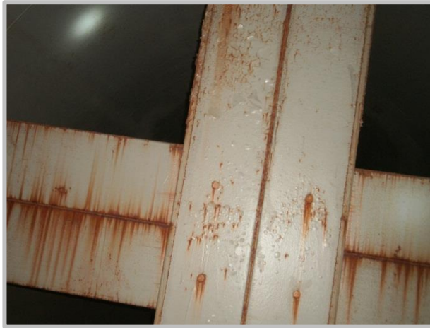
Fotografía 29: Rompeolas con inicios de corrosión.
