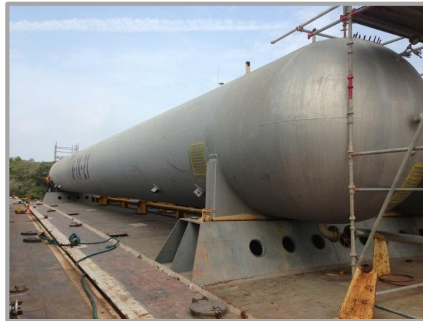
Fotografía 35: Recubrimiento externo.
