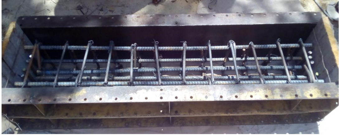
Figura 25. Refuerzo y formaleta de vigas.
