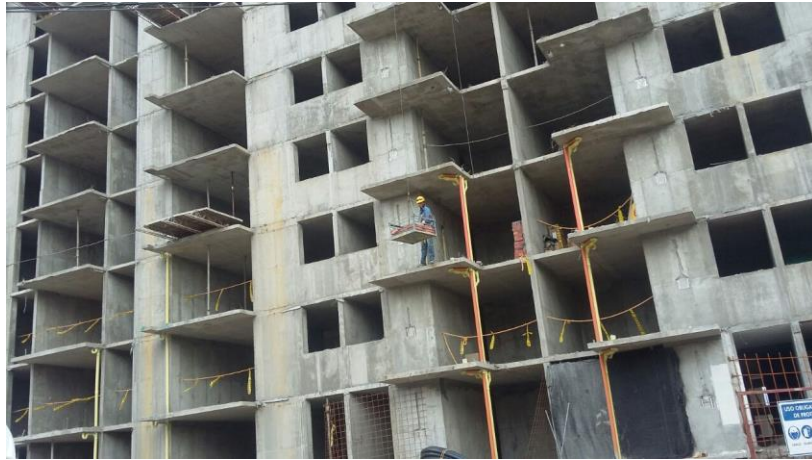
Figura 31. Estructura en construcción-San Lorenzo Reserva.
