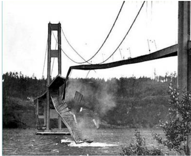
Figura 4. Colapso del puente de Tacoma.
