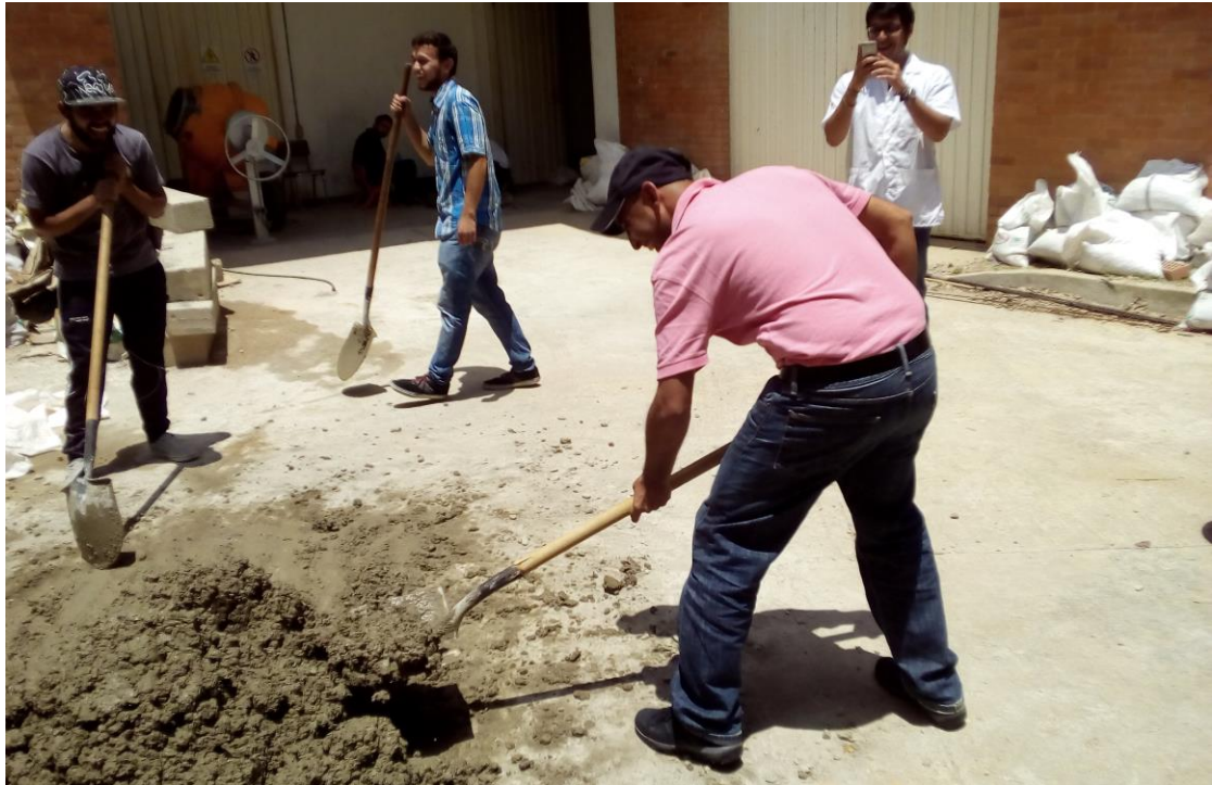
Figura 24. Mezcla del concreto para vigas.
