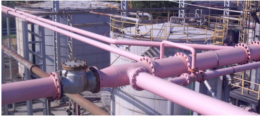
Figura 10. Bolsillos presentados en las líneas, llegada al cabezal de alivio de 6”
