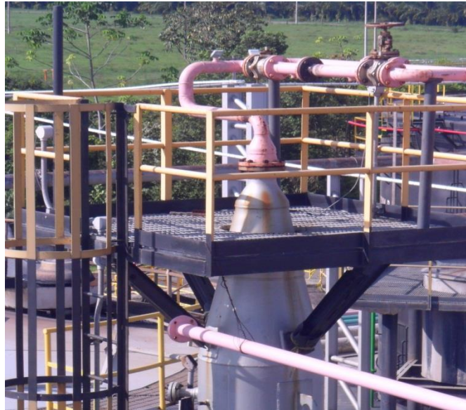
Figura 9. Separador gas/líquido (Bota).
