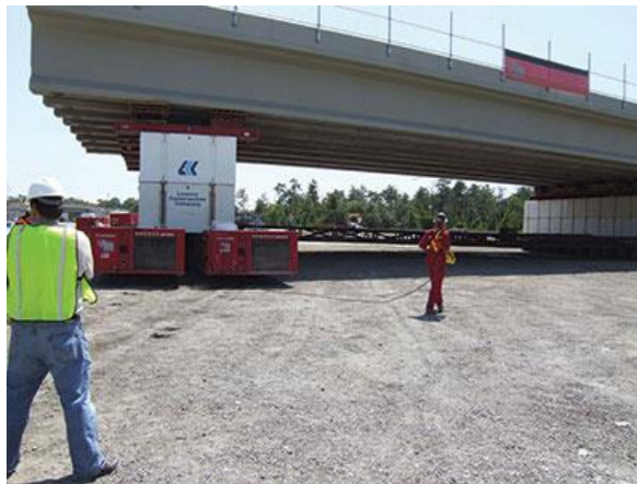
Figura 1. Superestructura a colocar sobre la avenida FDOT Graves
