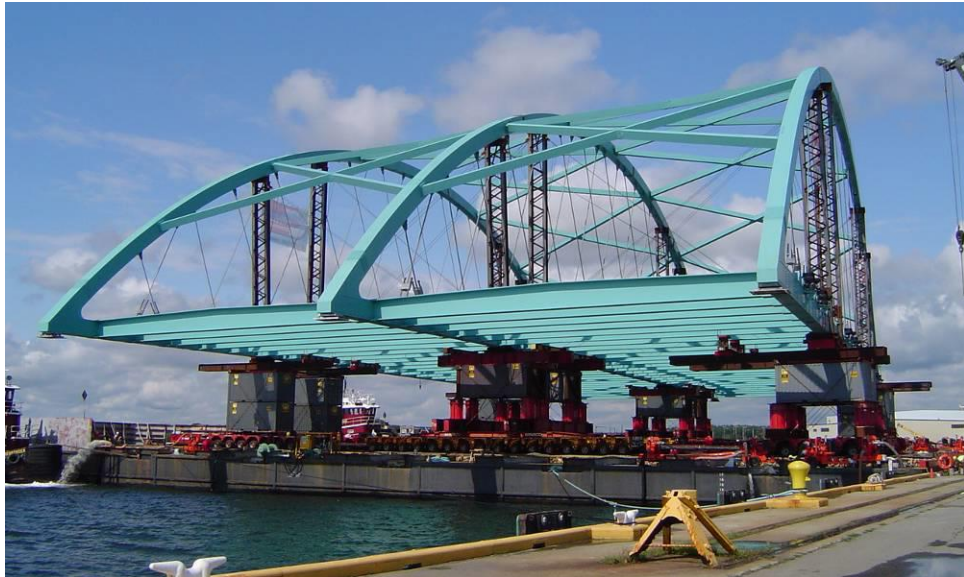
Figura 12. Puente en Rhode Island, Estados Unidos
