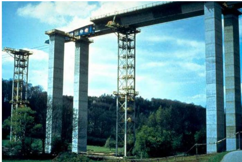
Figura 28. Colocación de pila auxiliar
