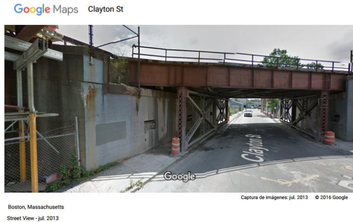
Figura 23. Puente metálico antiguo de la calle Clayton, Boston, USA
