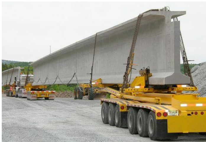
Figura 7. Transporte de una viga prefabricada de sección
