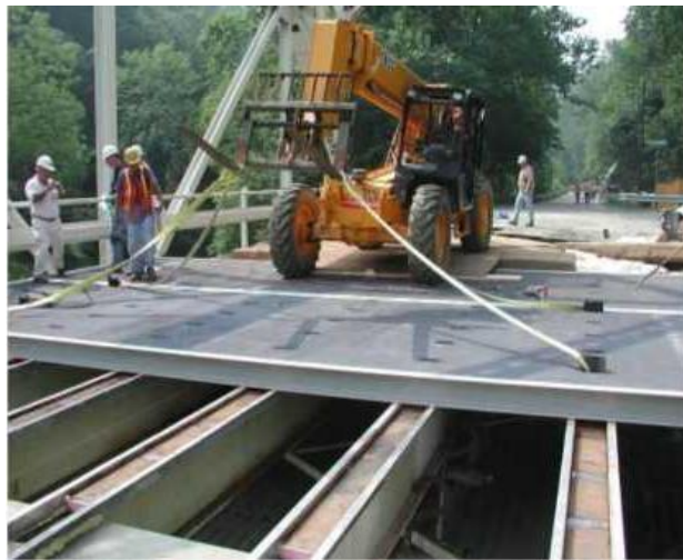
Figura 4. Instalación de tablero prefabricado
