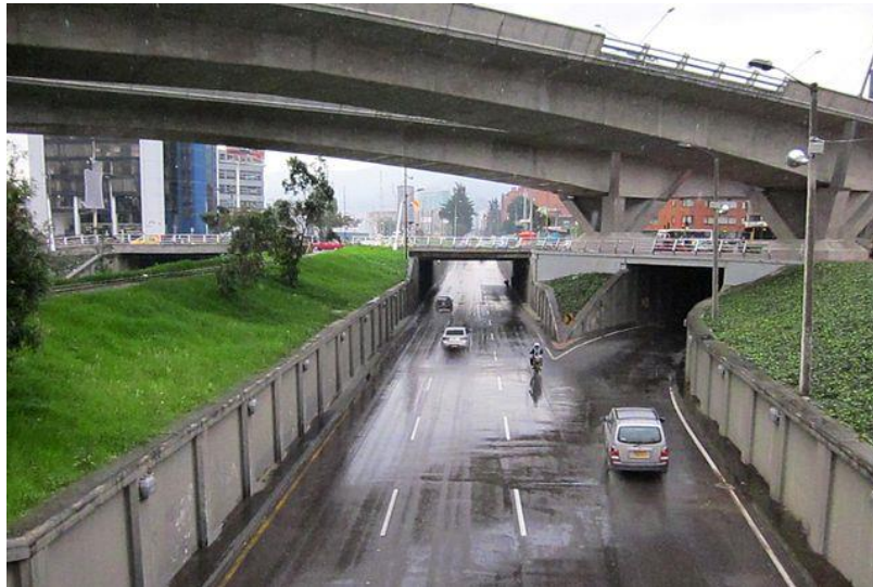
Figura 32. Puente de la calle 100 sobre la carrera 15 en Bogotá
