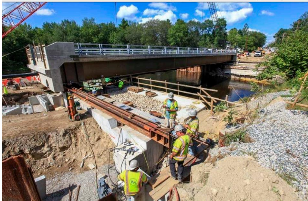
Figura 19. Preparación del equipo de arrastre para realizar el deslizamiento horizontal (USA)
