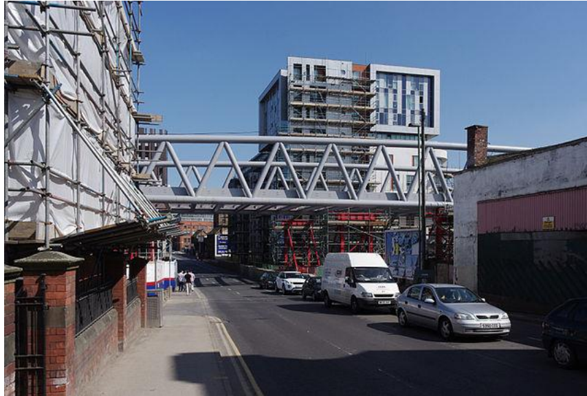
Figura 21. Traslado de sección de puente la Amistad en Karlsruhe, Alemania
