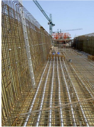
Figura 36. Colocación del cable postensado y refuerzo de la viga cajón
