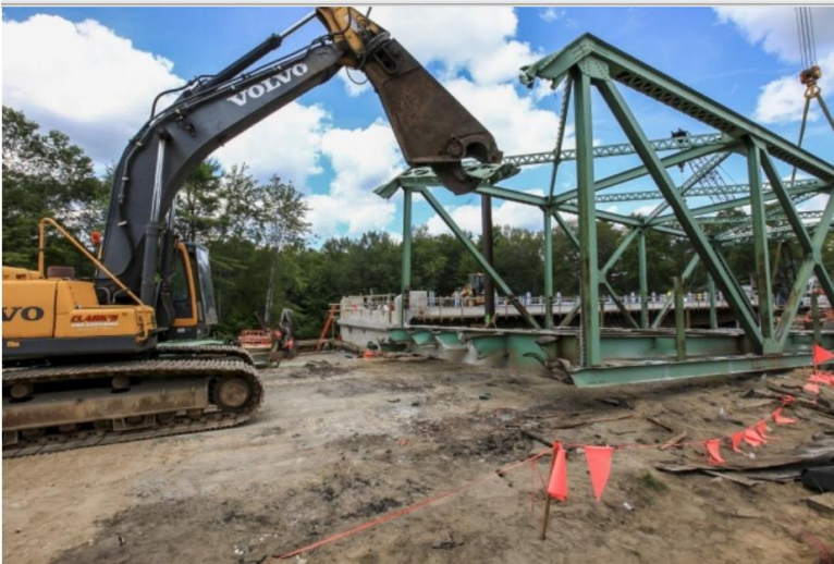
Fuente: Reproducido de ( http://www.fhwa.dot.gov/hfl/projects/me_pbes_superstructure_slidein_technology_hotelrd.pdf )
