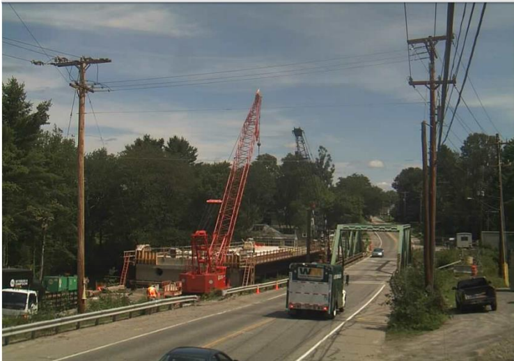
Fuente: Reproducido de ( http://www.fhwa.dot.gov/hfl/projects/me_pbes_superstructure_slidein_technology_hotelrd.pdf )
