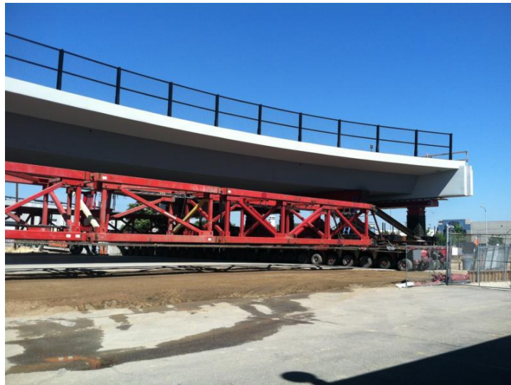
Figura 26. Transporte de la superestructura puente Pecos, en Denver, USA
