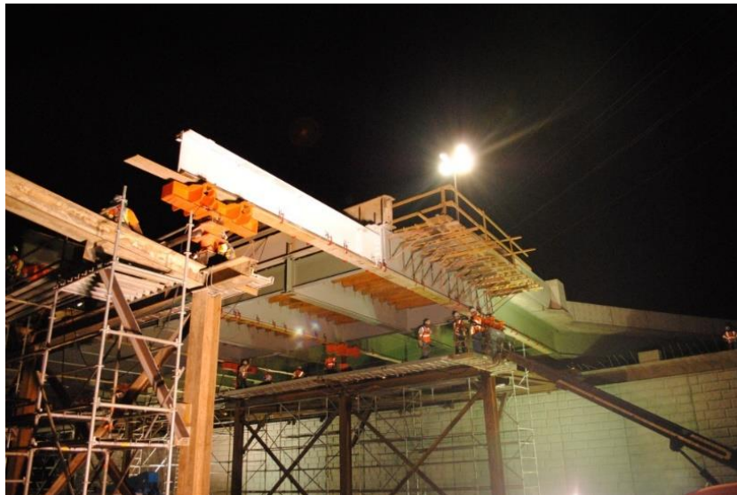
Figura 16. Lanzamiento longitudinal Puente Fort Lane I-15 – South Layton Interchange – Utah (USA)
