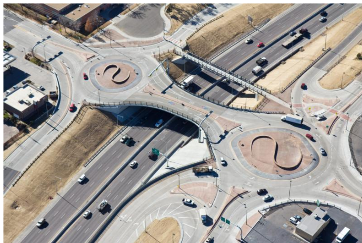
Figura 25. Puente en la calle Pecos con la interestatal 70, en Denver, USA
