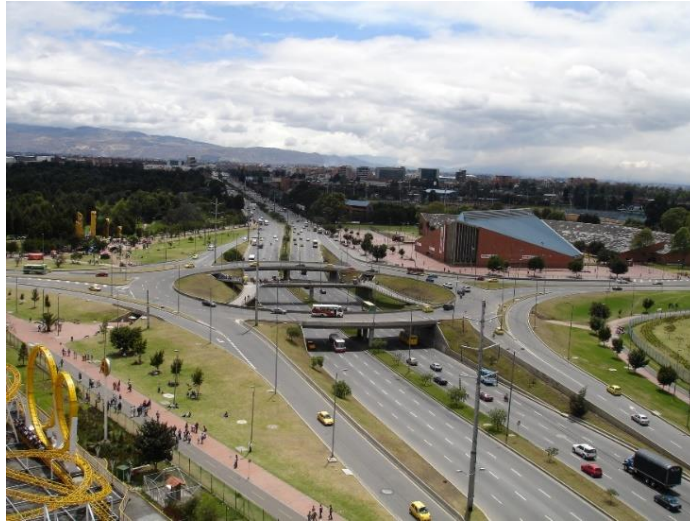
Figura 40. Puente avenida 68 con calle 63 en Bogotá
