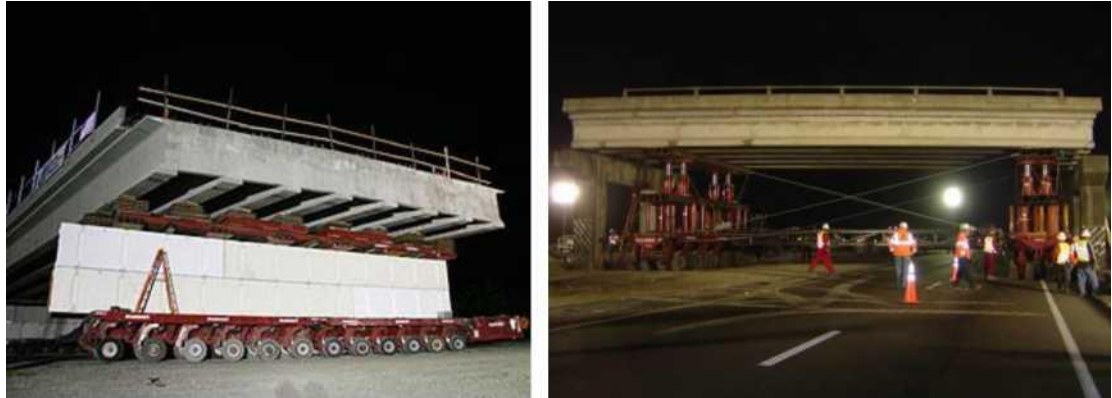
Figura 2. Instalación de la superestructura sobre la avenida FDOT Graves
