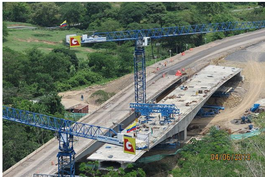
Figura 20. Torre grúa sobre construcción de puente
