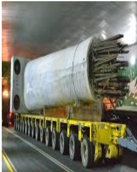
Figura 5. Levantamiento columna prefabricada 18 m.
