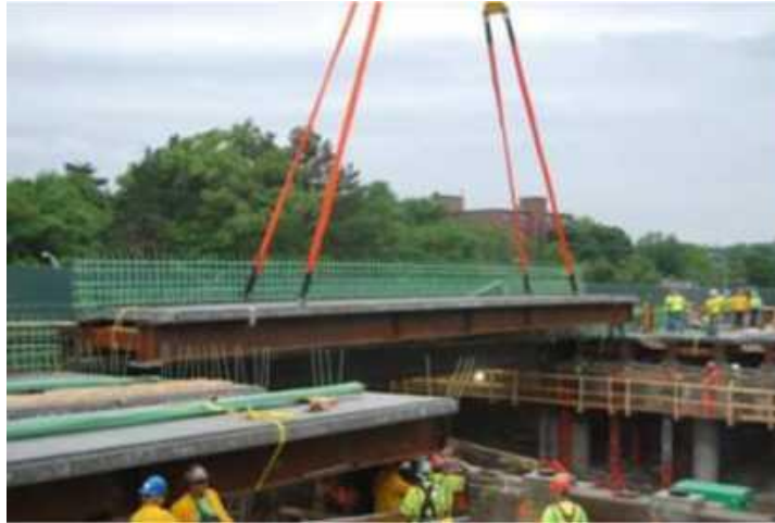
Figura 6. Instalación de vigas prefabricadas
