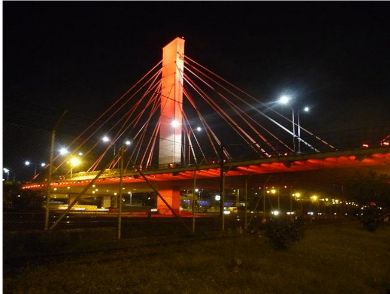
Figura 35. Puente Gilberto Echeverri Mejía en Medellín
