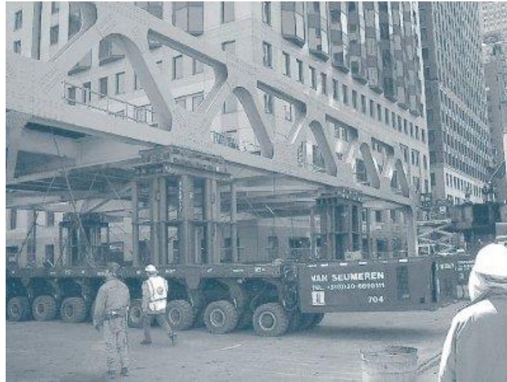
Figura 13. Traslado de superestructura por medio de SPMTs
