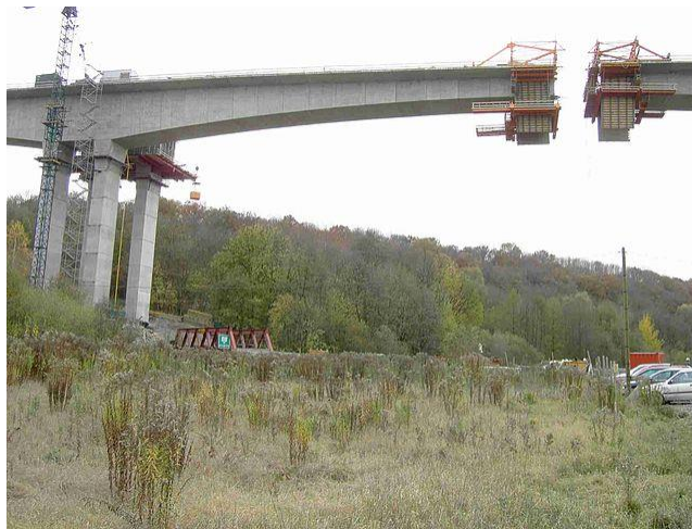
Figura 29. Finalización de tramo a falta de una dovela
