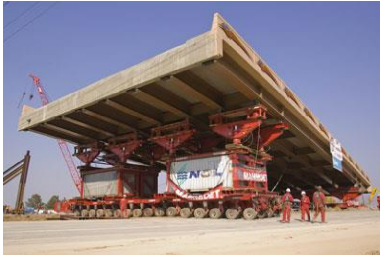
Figura 14. Traslado de sección de 1500 ton, Puente 4500 del Sur sobre la I-215 en Salt Lake City
