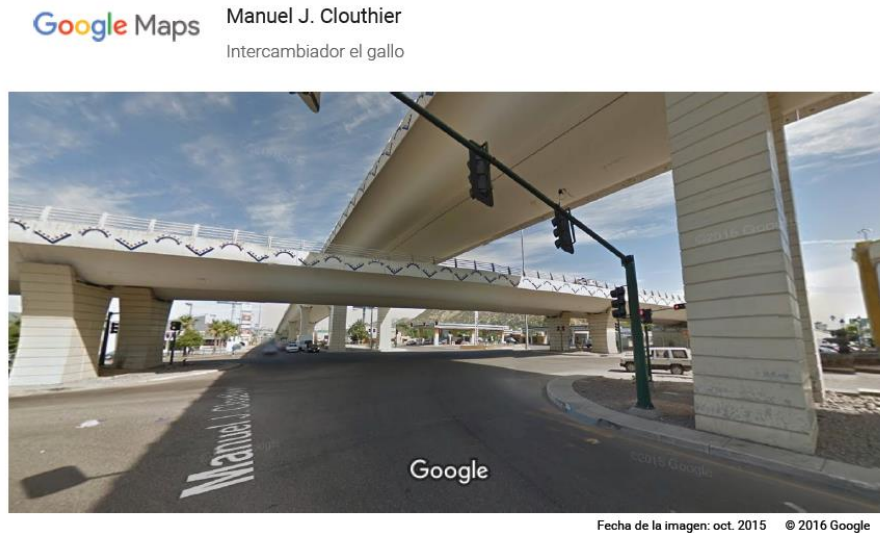
Figura 22. Distribuidor vial el Gallo y puente Quiroga, en Hermosillo, México
