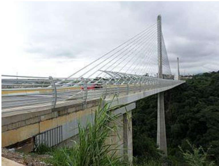
Figura 34. Puente Provincial. Viaducto la novena en Bucaramanga
