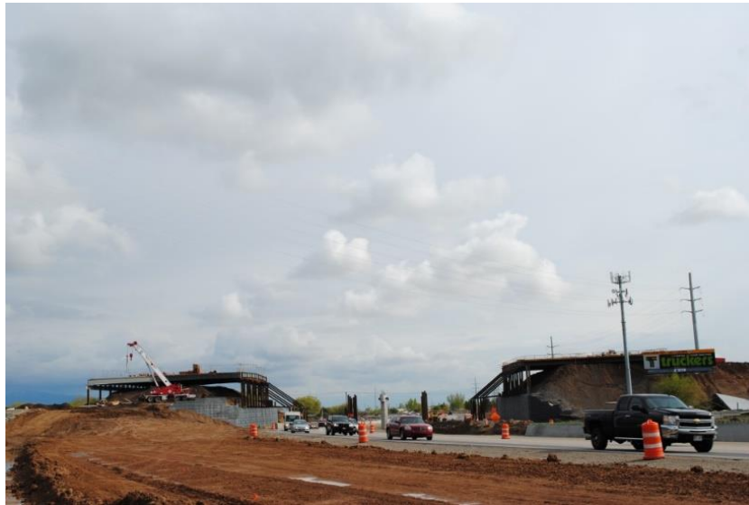
Figura 15. Construcción Puente Fort Lane I-15 – South Layton Interchange – Utah (USA)
