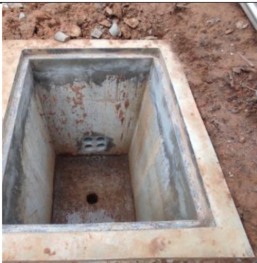
Figura 40 Suministro e instalación de caja CS 276 correspondiente a la remodelación de la red eléctrica de Nivel II
