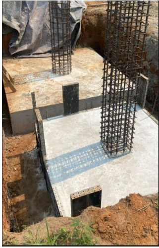
Figura 14 Vaciado de concreto de 3500 PSI para zapatas del eje G (16 – 17)
