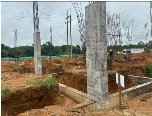
Figura 24 Concreto de 3500 PSI para columna del eje N – 5 del bloque de aulas.
