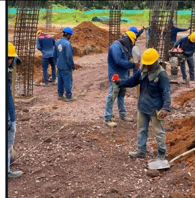
Figura 29 Trabajo de toma de niveles para posterior compactación del relleno con material granular
