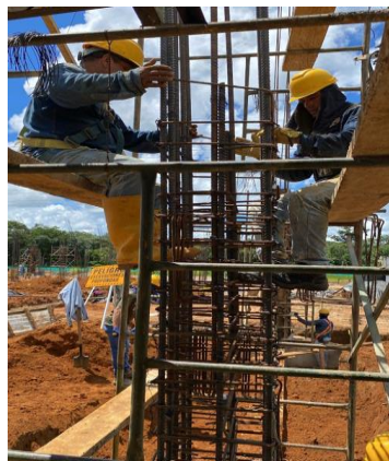
Figura 58 Armado de acero de refuerzo para columnas del bloque administrativo.
