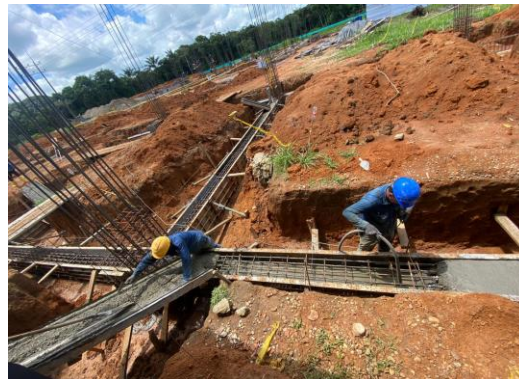
Figura 54 Concreto de 3500 PSI para viga de cimentación del eje A (16 – 17)
