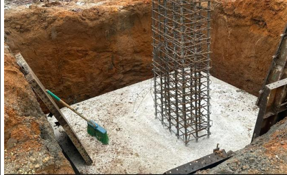
Figura 17 Vaciado de concreto de 3500 PSI para zapata del eje M – 6 del bloque
