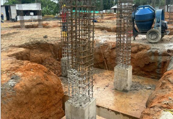
Figura 16 Vaciado de concreto de 3500 psi para zapatas del eje D (16 – 17)
