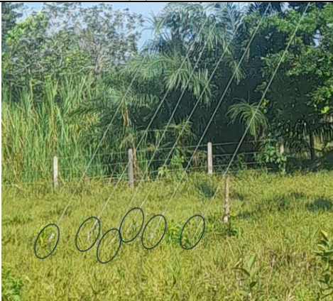
Figura 34 Estructura doble NC 550 de subterranización, para dejar operativo el circuito dos (2)
