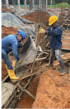
Figura 55 Concreto de 3500 PSI para vigas de cimentación eje 17 (J – L)
