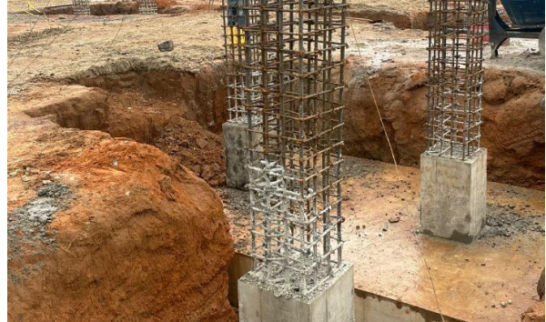
Figura 23 Concreto de 3500 PSI para pedestales del eje G (16 – 17) del bloque administrativo.
