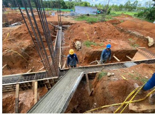
Figura 56 Concreto de 3500 PSI para vigas de cimentación del eje 12 (E – G).
