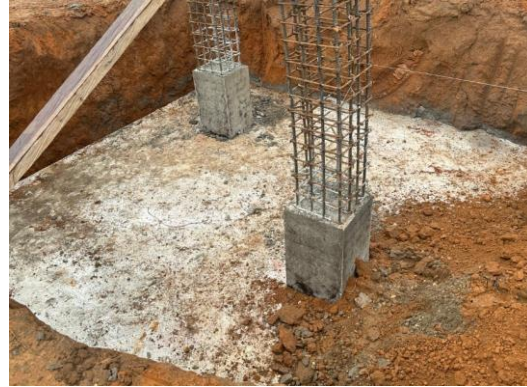
Figura 15 Vaciado de concreto de 3500 PSI para zapata de eje E – F (16 – 17).
