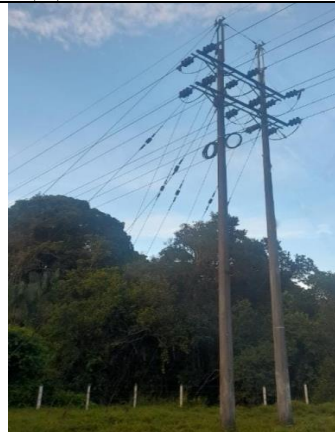
Figura 35 Estructura doble NC 550 de subterranización, para dejar operativo el circuito dos (2)
