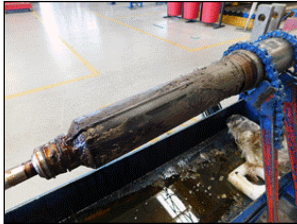
Figura 25 Cámara superior de bolsa con sólidos en el exterior
