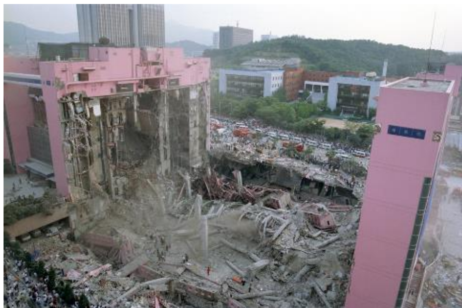
Figura 12. Otra vista del derrumbe del edificio Sampoon, Seúl - Corea del Sur. Adaptado de (Kari, 2019).
