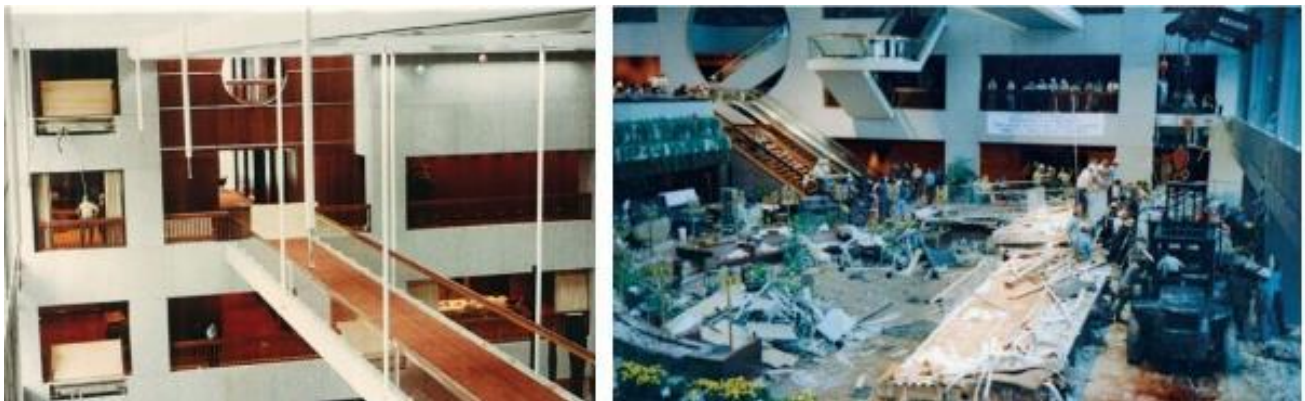
Figura 13. Accidente en el Hotel Hyatt Regency de Kansas City, EEUU. Adaptado de [Fotografía de Julio Ching]. (EEUU, 2017). Archivos fotográficos del Blog estructurando.
