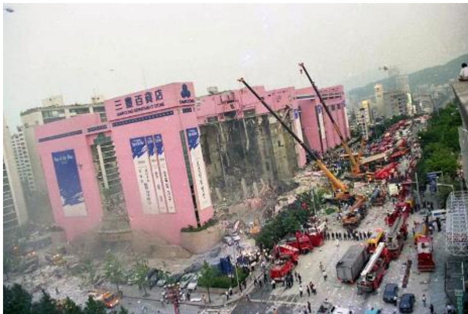
Figura 11. Derrumbe del edificio de las Tiendas Sampoong, Seúl - Corea del Sur. Adaptado de (Almarwae, 2017).
