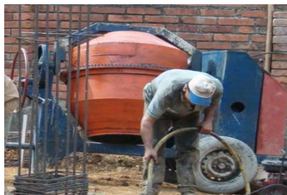
Fuente: Fotografías tomadas por alumnos durante la construcción del edificio de pesados
