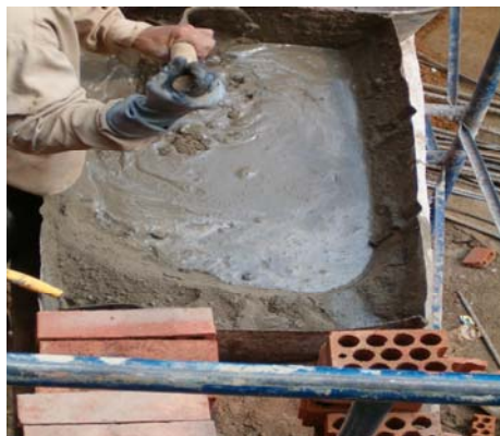
Fotografía 5. Preparación y transporte de la mezcla, pegue de ladrillos
