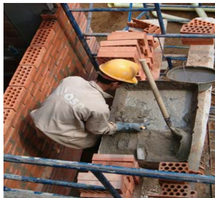
Fotografía 5. Preparación y transporte de la mezcla, pegue de ladrillos
