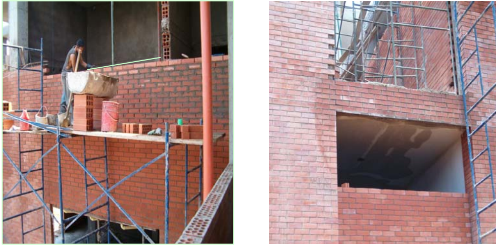
Fotografía 6. Verificación y nivelación, limpieza del muro
