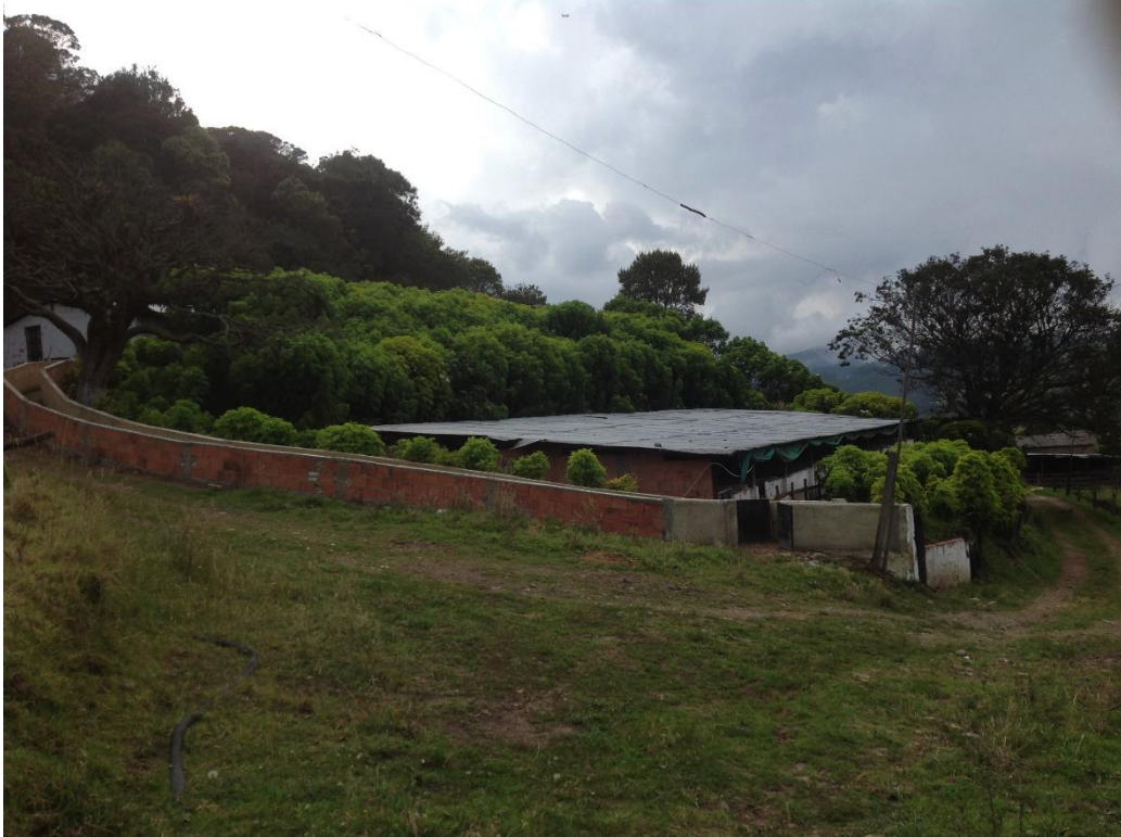
Foto 8. Infraestructura de la explotación porcina.
