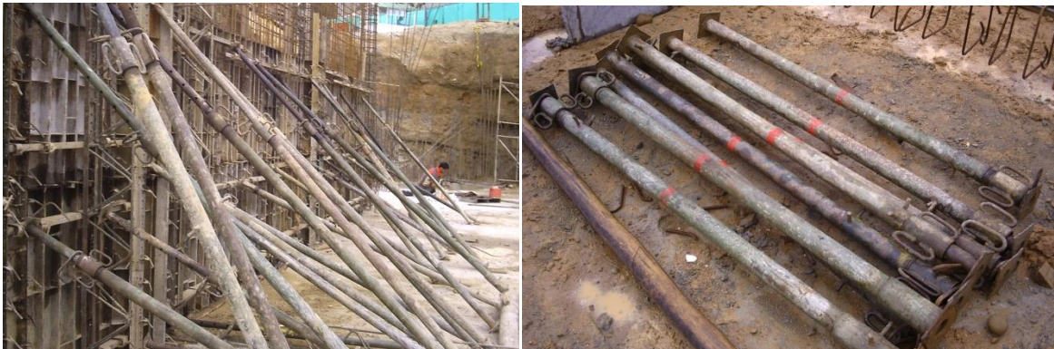
Figura 53: Paral telescópico corriente
