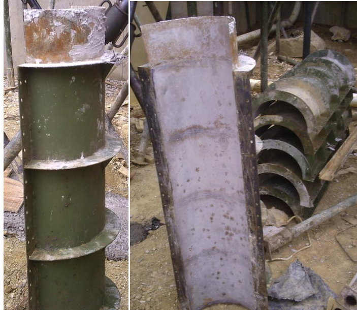
Figura 45: Tablero circular metálico
