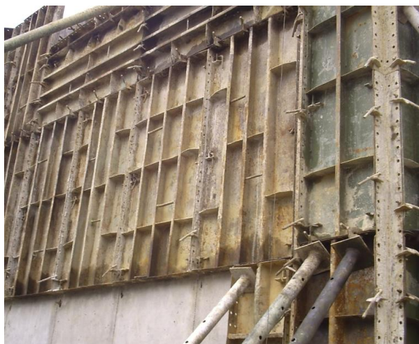
Figura 43: Tableros modulares metálicos
