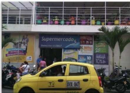
Figura 2. Fachada del Supermercado Parque Condominio
