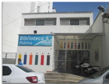
Figura 1. Fachada de la Biblioteca Pública Parque Condominio
