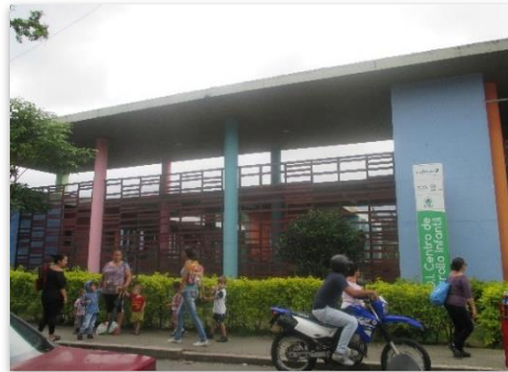
Figura 5. Fachada del CDI Zapamanga II
