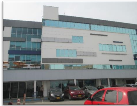
Figura 4. Fachada de la sede Administrativa Puerta del Sol
