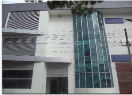
Figura 3. Fachada del Centro Empresarial Puerta del Sol
