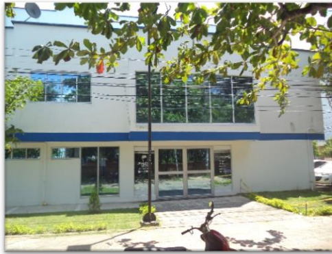
Figura 9. Fachada del acceso al CIS y centro empresarial de Barrancabermeja
