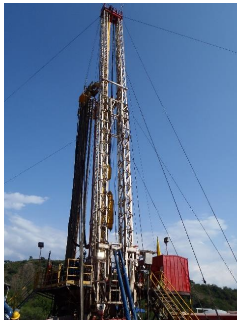
Figura 2. Torre del taladro. Carreño, W.2017.
