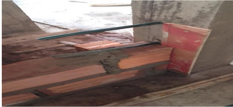
FIGURA 5: Construcción del muro con varilla anclada
