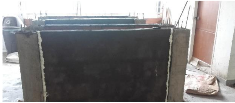
FIGURA 7: Muro con espuma de poliuretano cubriendo la totalidad de la dilatación.
