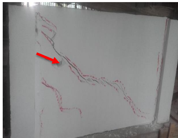
FIGURA 13: Falla por deslizamiento.
