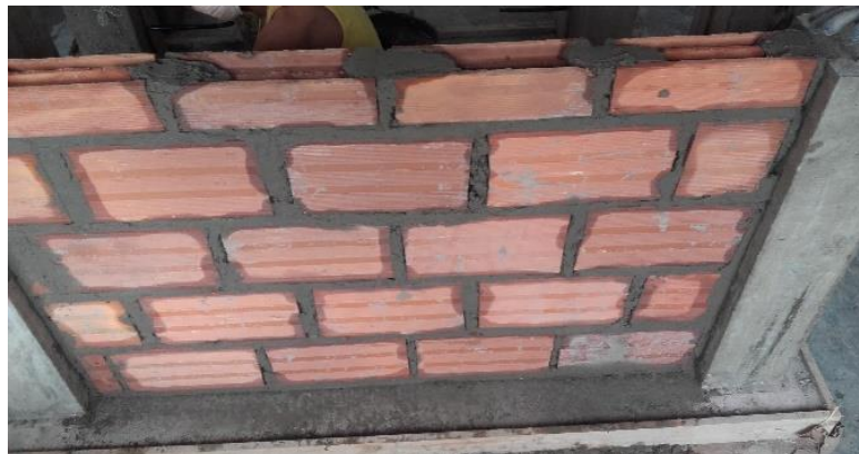
FIGURA 4: Muro convencional terminado en ladrillo H-10
