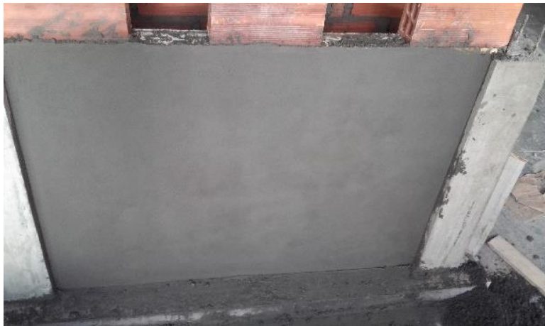
FIGURA 6: Muro frisado completamente.
