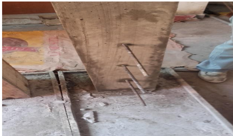
FIGURA 2: Columna desencofrada.
