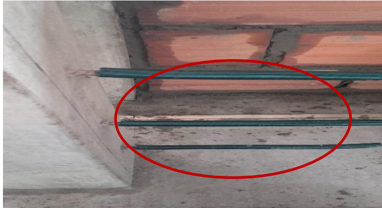
FIGURA 3: Recubrimiento de barras de acero.
