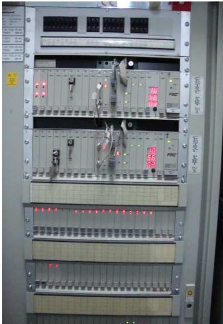
Ilustración 12. Sistema de parada de emergencia (FSC)
