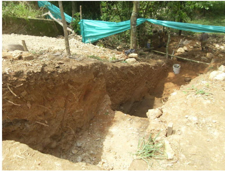
Fotografía 1. Canal de aguas lluvias
