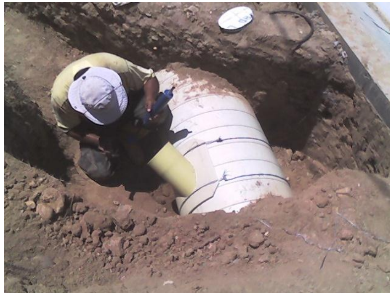
Fotografía 3. Acometidas Domiciliarias (Silla Y)
