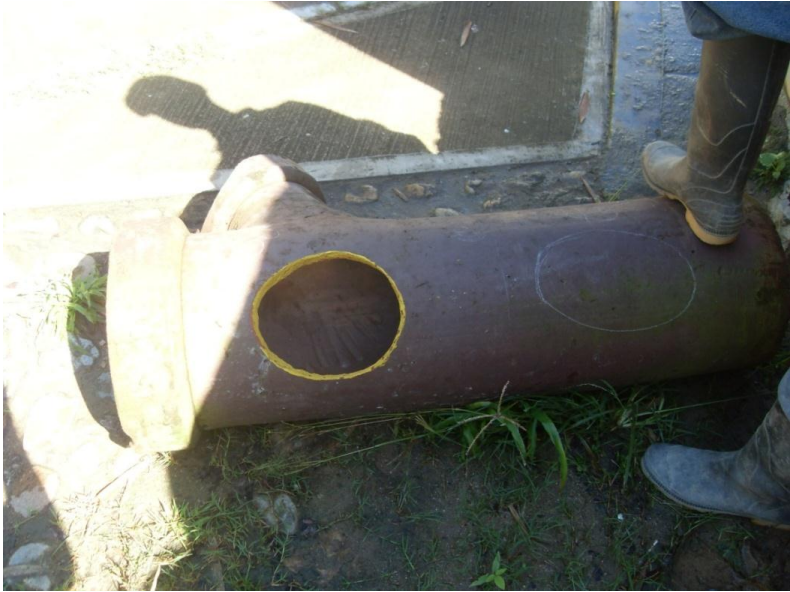
Fotografía 5. Acometidas Domiciliares (Conexión Galapago)
