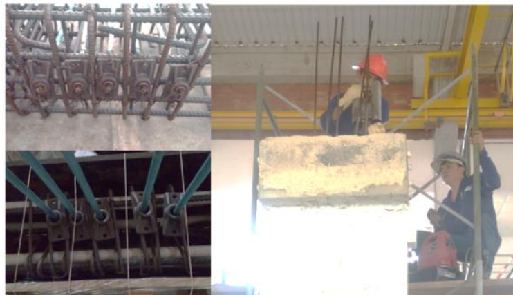
Figura 12. Cables de postensado, platinas y aplicación de fuerza axial con gato hidráulico.
