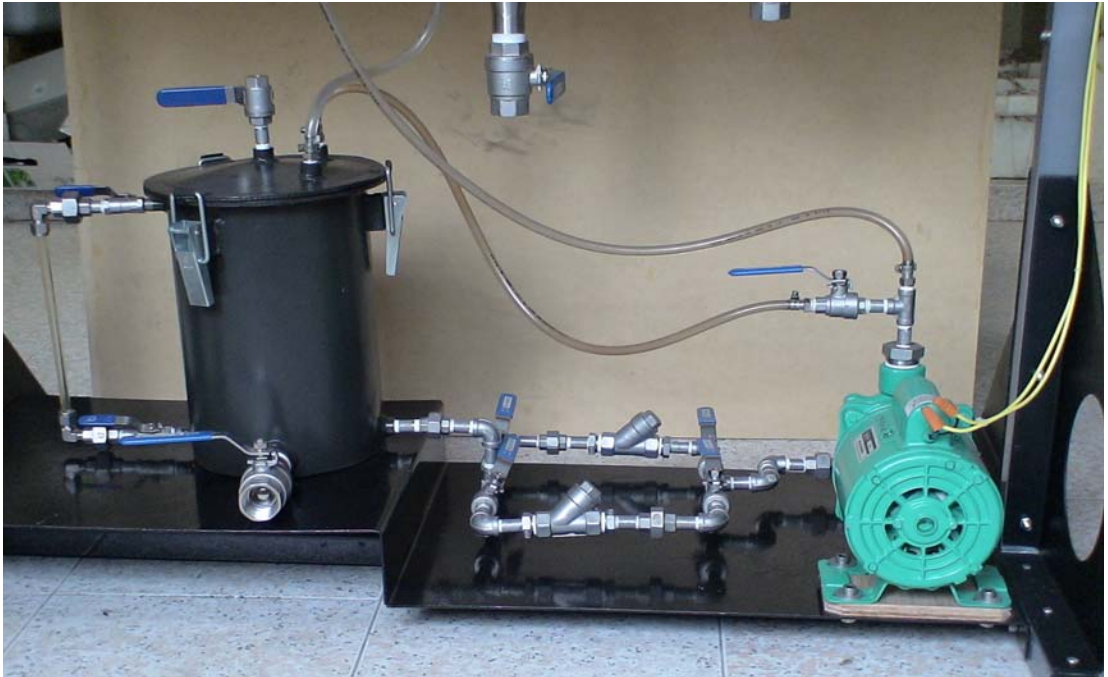
Figura C.11. Fotografía del montaje tanque de retorno-sistema de filtros-bomba centrífuga
