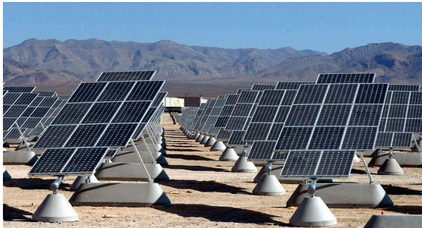
Figura 13. Soporte de un seguidor con un grado de libertad.
