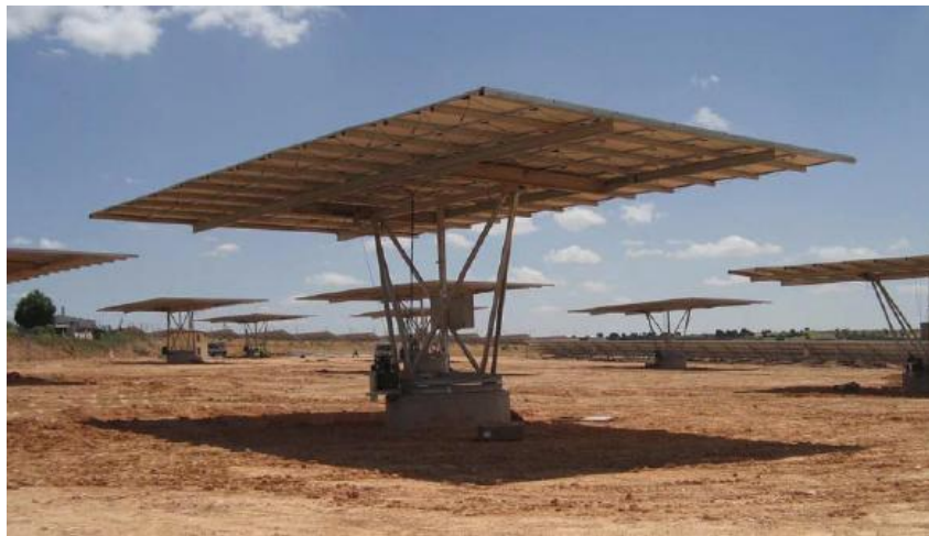
Figura 14 Soporte de un seguidor con dos grado de libertad.
