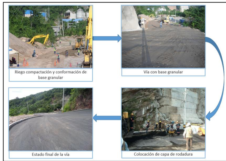
Figura 5. Proceso de pavimentación de la vía de acceso a la Central Subterránea de Hidrosogamoso.
