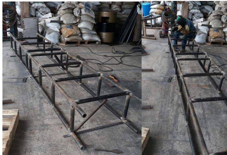
Figura 37. Torre de perforación.
