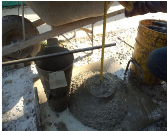
Figura 10: Asentamiento del concreto
