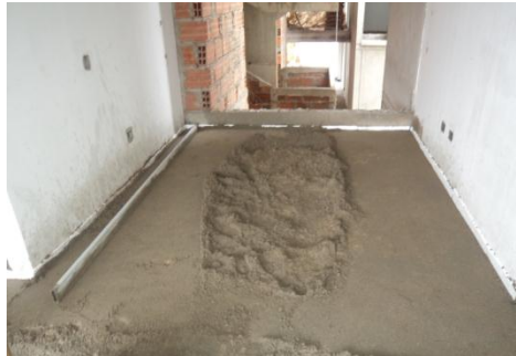
Figura 8: Mortero para piso
