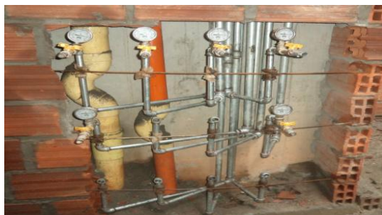
Figura 20: Prueba de Hermeticidad
