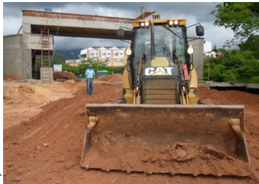
Figura 23 Movimiento de tierra
