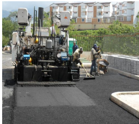
Figura 24: Conformación de la capa asfáltica
