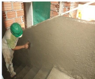
Figura 6: Pañete en punto fijo
