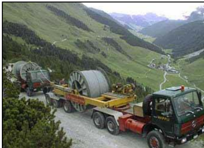
Figura 7. Acarreo de cables
