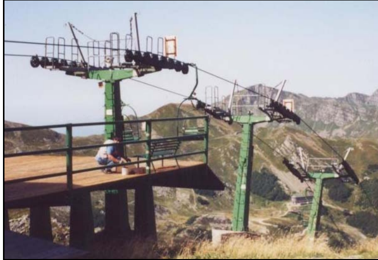
Figura 16. Torres con Rodillos Para Desviar el Cable
